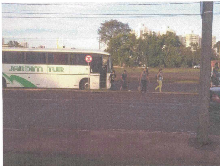
Figura 9: Faixa de pedestres desgastada no entorno do empreendimento. Fonte: Master Ambiental, 2013.
