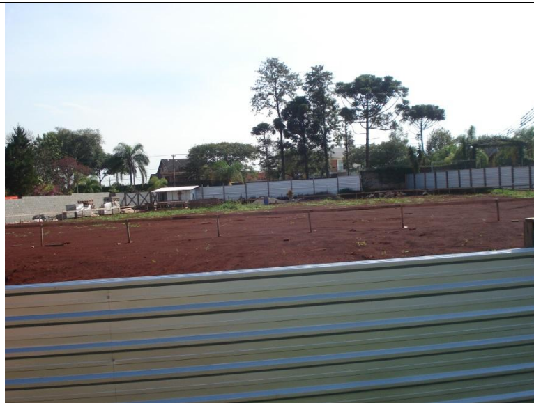
Figura 10 - Foto do Interior do Lote
