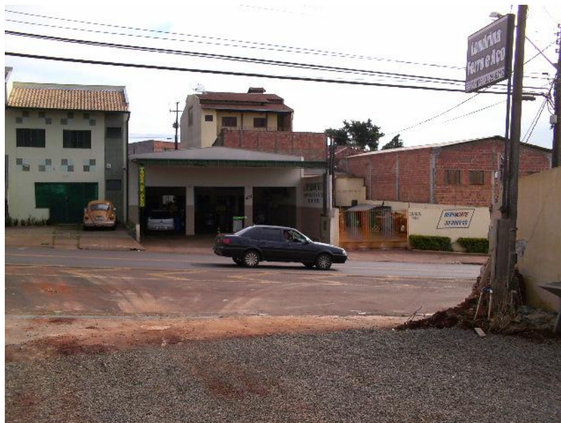
Imagem 04 - Vista frontal do empreendimento e da rodovia João Carlos Strass;
