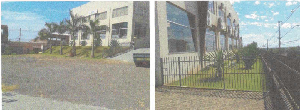
Figura 7: Vista da vegetação paisagística observada no local.
