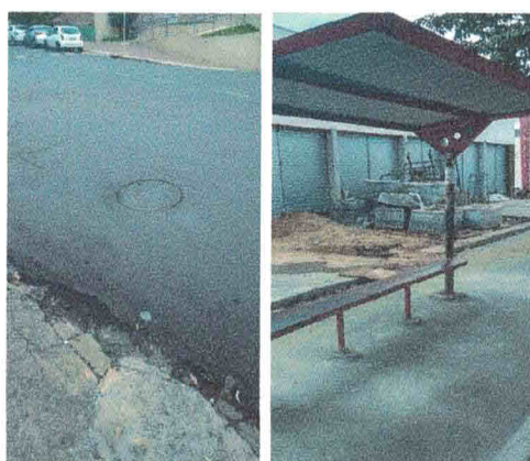
Figura 9: Equipamentos Urbanos da AID.
