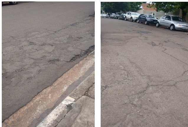
Figura 9: Pavimentação da Rua Borba Gato.
