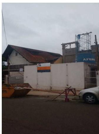
Figura 1: Terreno onde está sendo construído o empreendimento.
