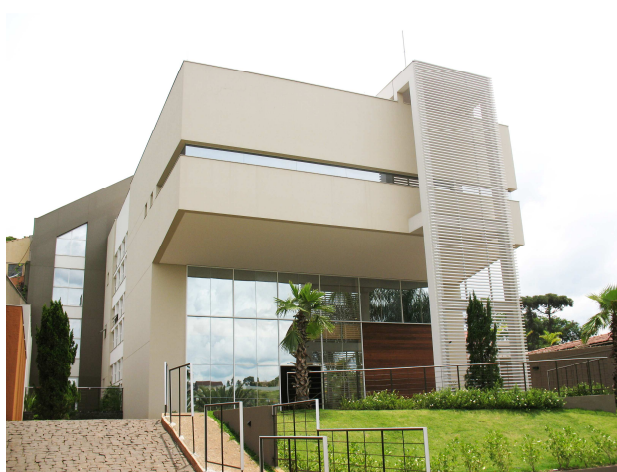
Figura 1: Vista frontal do hospital.
