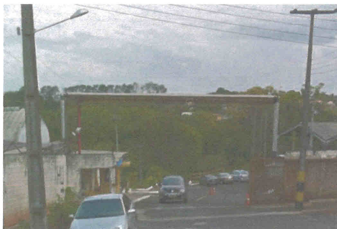
Figura 27: Entrada e saída do estacionamento do HU da Rua Sidrack Silva.
