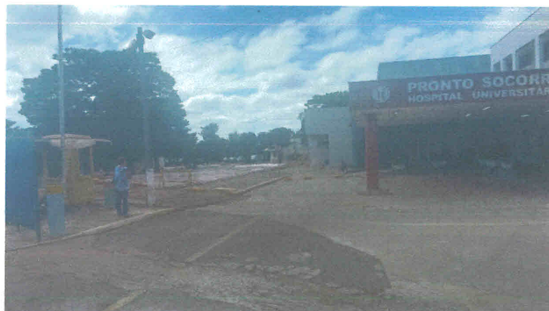
Figura 23: Entrada de veículos no Pronto Socorro.
