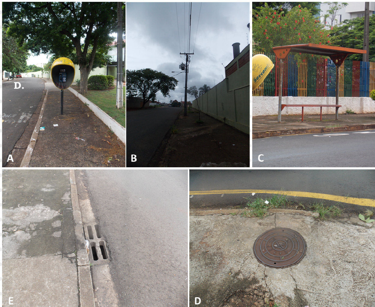
Figura 17: Infraestrutura pública existente na Área de Influência Direta. (A) Telefonia pública, (B) rede de energia elétrica, (C) ponto de transporte público, (E) rede de drenagem e (F) galeria de estomente sanitário.
