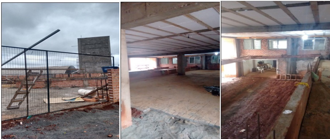
Figura 2: Construção da igreja.
