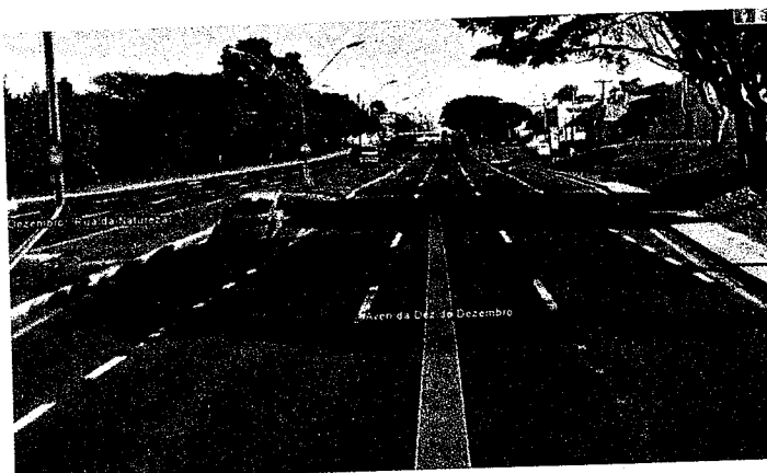
Figura 90: Avenida Dez de Dezembro, e sua sinalização horizontal, demarcando as pistas de rolamento e a proibição de estacionar de ambos os lados, além da baía a esquerda e acesso a marginal a direita. Fonte: Google Street View (2011).
