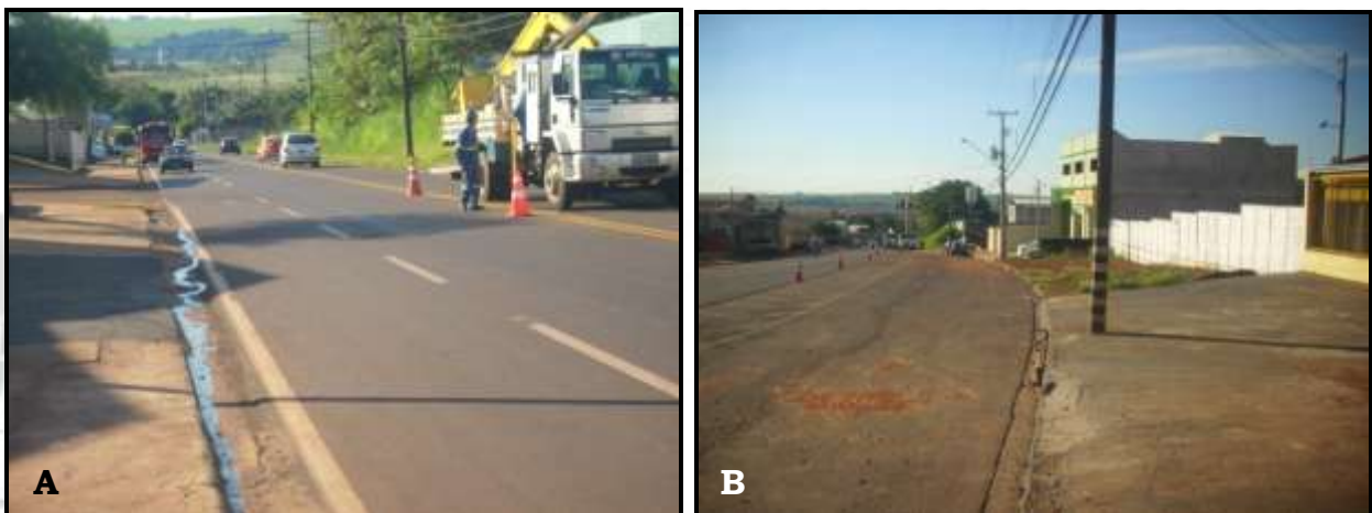
Figura 04: Vista geral do Av. Ludwig Ernest (lado do futuro estacionamento do supermercado). Legenda: (A) declividade do terreno em direção sul-norte; e (B) desvio para acesso ao futuro estacionamento (delimitado pelo tapume branco).
