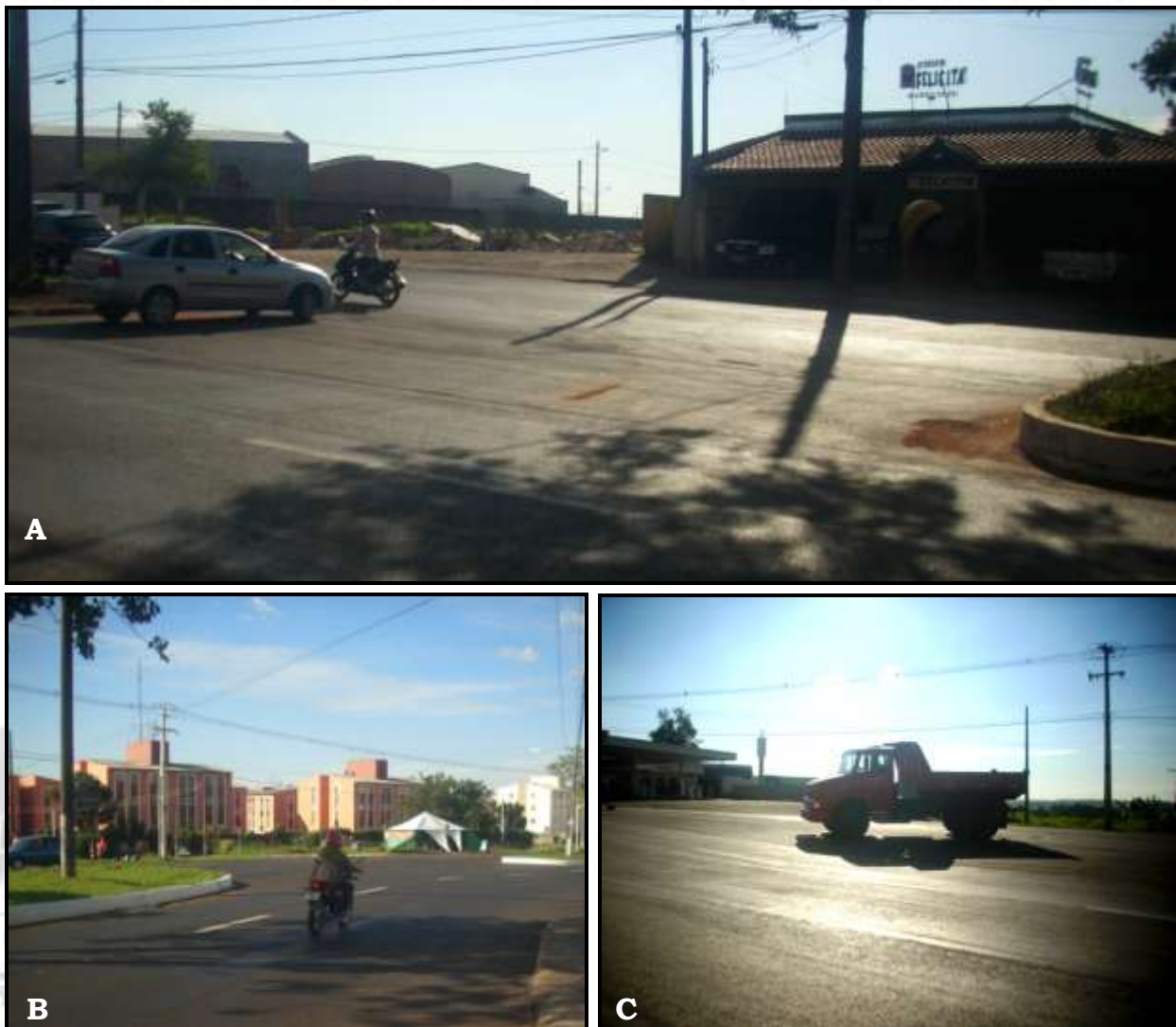
Figura 12: Ausência de sinalização horizontal e de placas indicativas de movimentação permitida (conversões) em uma das vias de acesso ao empreendimento.
