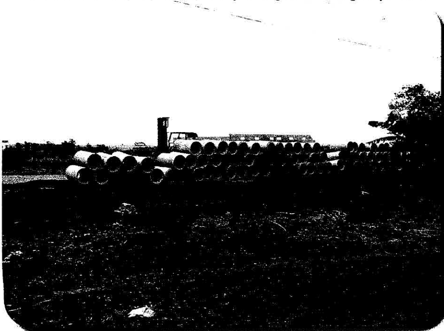
Figura 3.9. Tubulação para implantação de galerias de águas pluviais.
