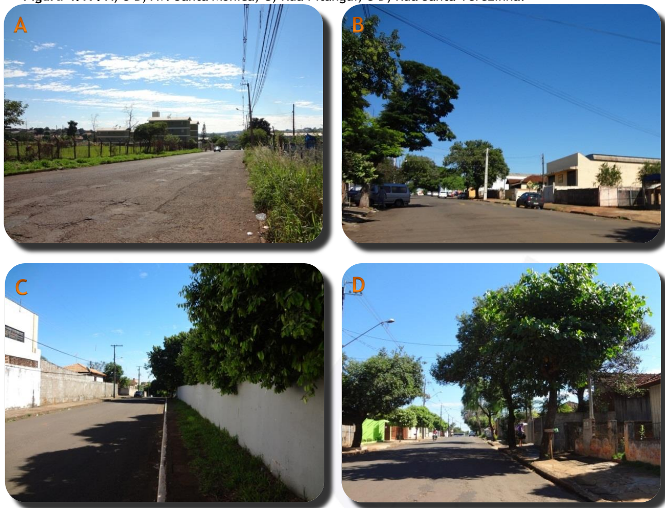
Figura 4.17. A) e B) Av. Santa Mônica, C) Rua Pitanguí; e D) Rua Santa Terezinha.
