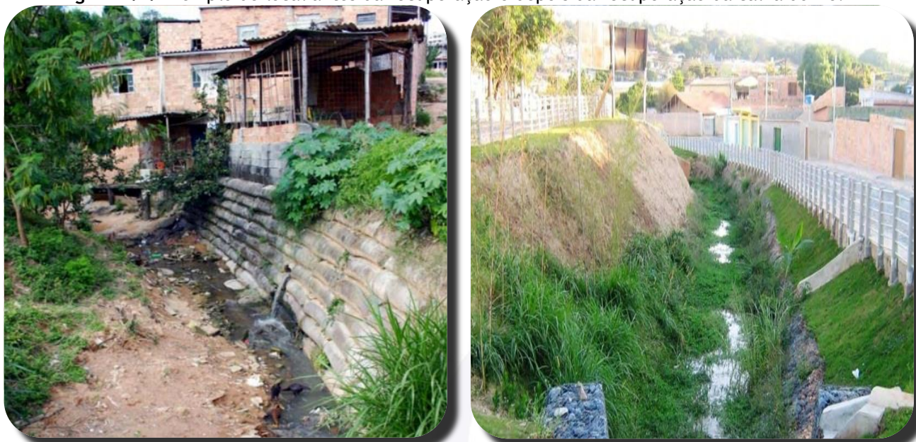
Figura 5.1. Exemplo de local antes da recuperação e depois da recuperação da calha do rio.
