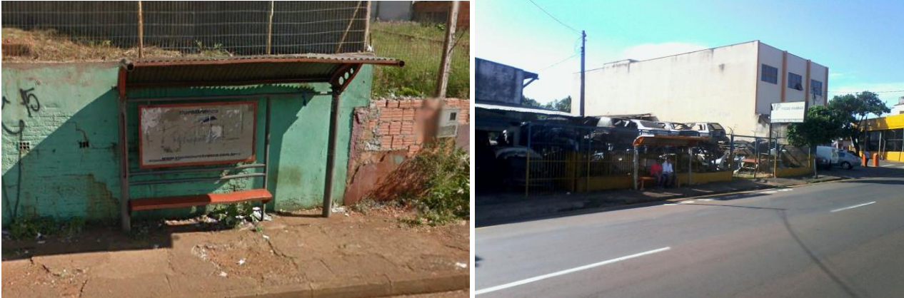
Figura 13: Pontos de ônibus próximo ao empreendimento.
