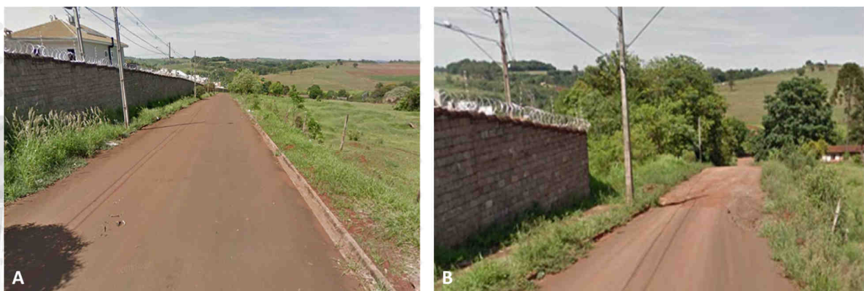
Figura 22: Pavimentação parcial da Av. B.
