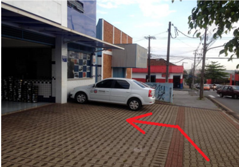
Figura 11 – Frente do empreendimento. 12/09/2016. Fonte: Vítor Ricci
