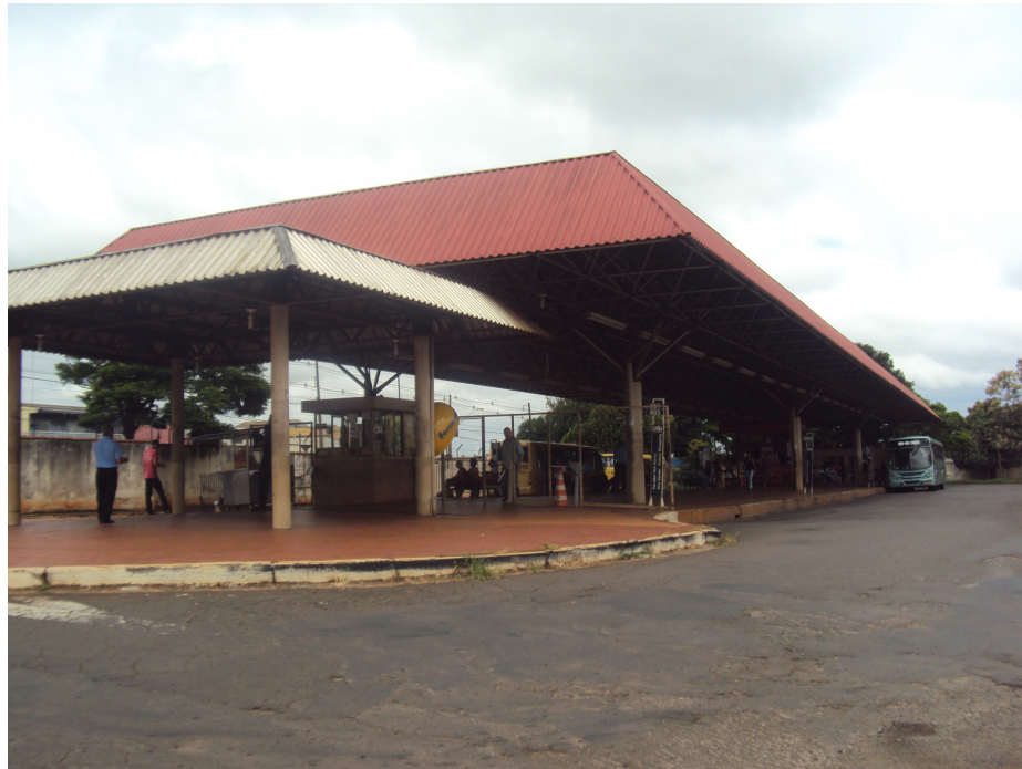
Terminal de bairro Vivi Xavier a 100m do lote.
