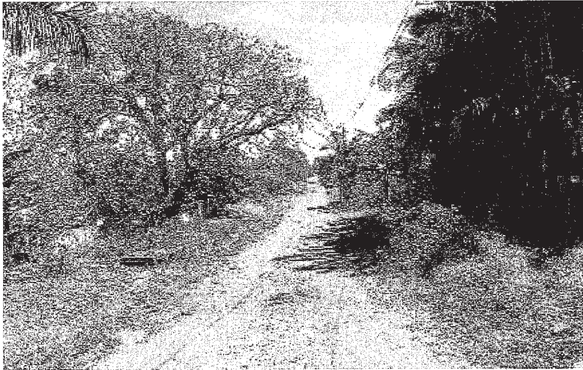
Figura 4.10 – Rua Vicente Poletti sem pavimentação e com predominância de ocupação por chácaras.
