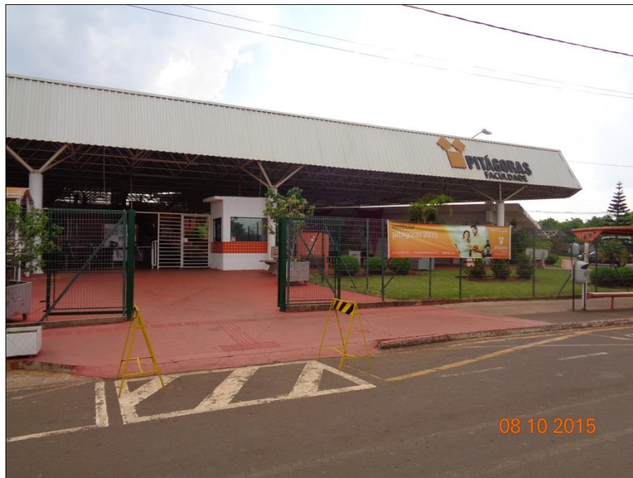
Figura 7: Acesso principal da Faculdade. Fonte: Master Ambiental.
