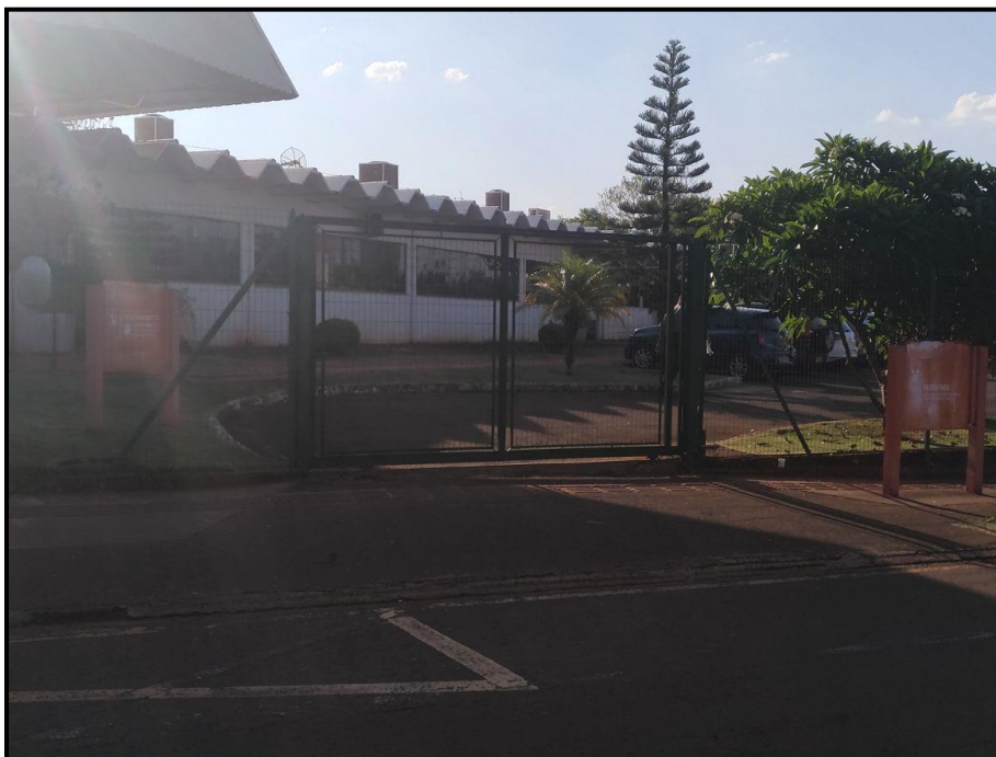
Figura 43: Acesso de veículos dos servidores e funcionários. Fonte: Master Ambiental (2017).
