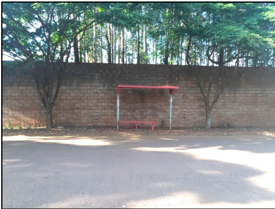
Figura 37: Ponto de ônibus (Ponto 2). Fonte: Master Ambiental (2017).
