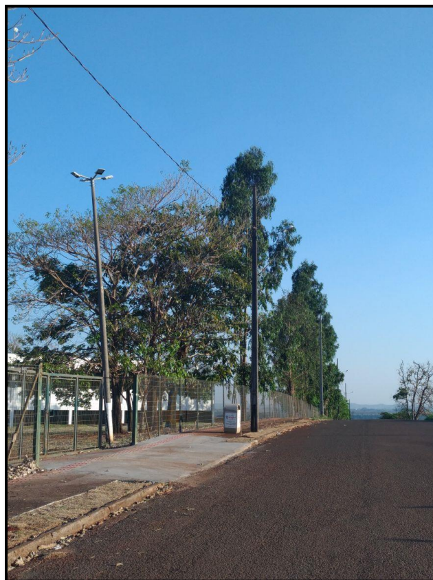
Figura 46: Acesso de veículos inutilizado. Fonte: Master Ambiental (2017).
