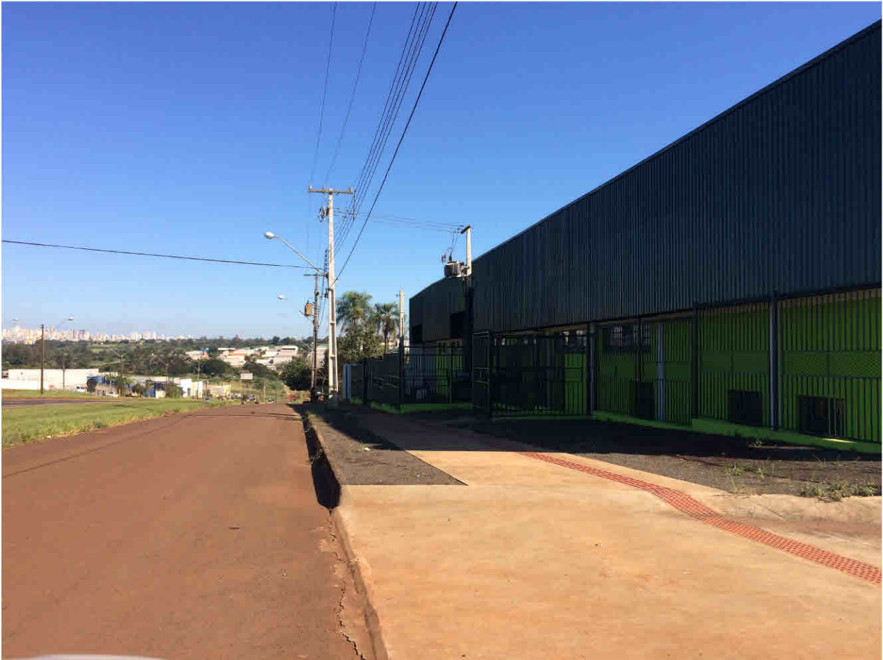
Foto n.06: Rua Marginal em frente ao lote em estudo.
