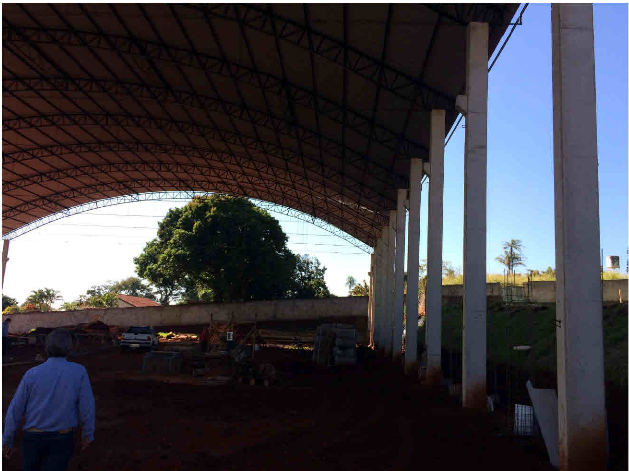
Foto n. 05: Vista interna do empreendimento - pé direito=13,00m
