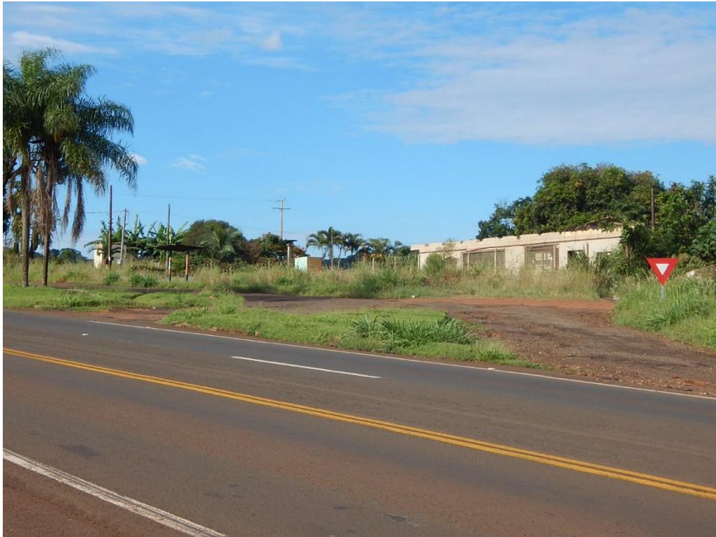
Figura 25. Aspecto da edificação adjacente a PR 445 defronte ao acesso da unidade Serrinha.
