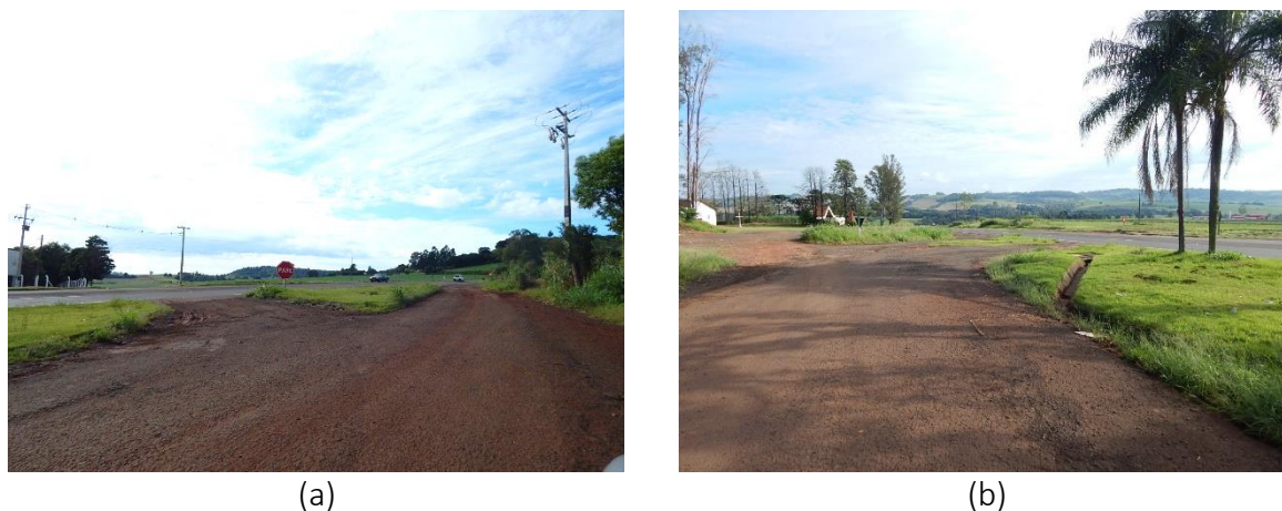
Figura 31. Acesso pela interseção canalizada da rodovia estadual PR 445, km 55.
