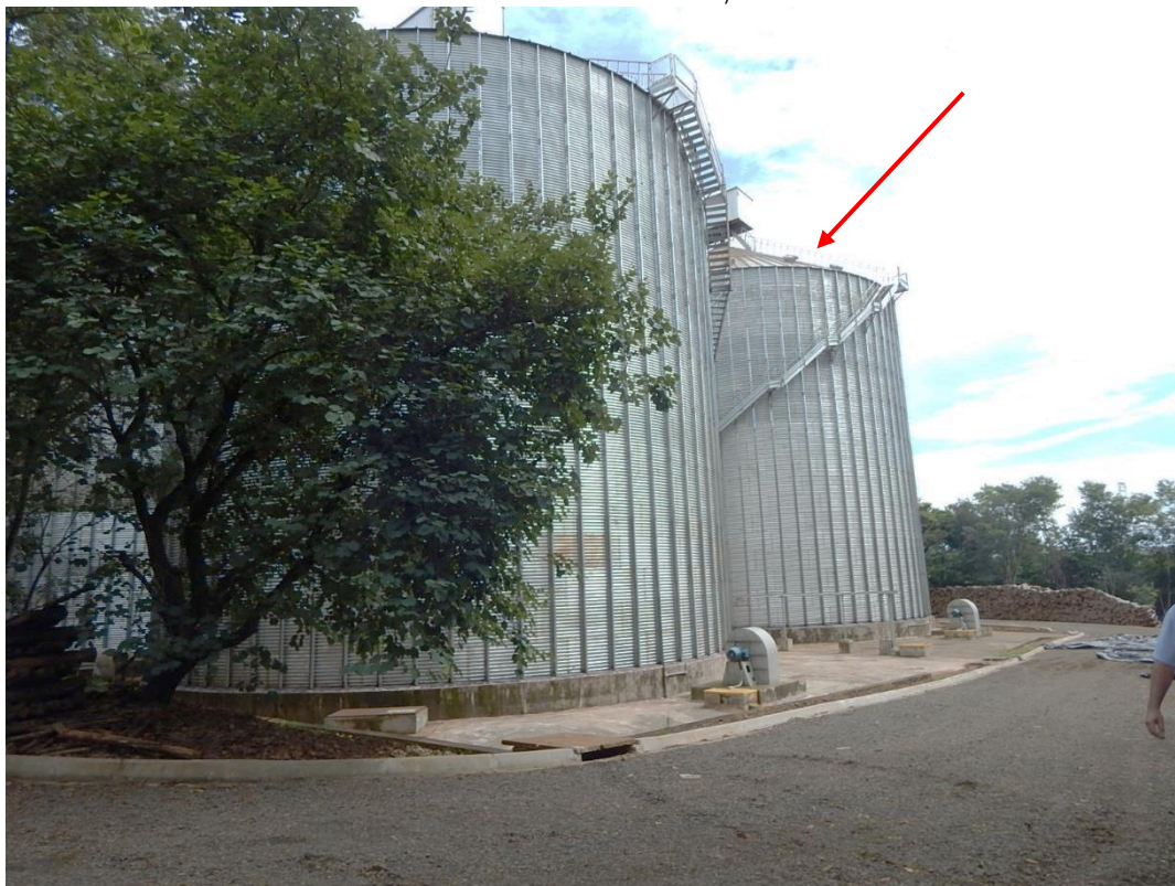
Figura 18. Aspecto dos silos de armazenagem e indicação dos dispositivos de trocar de massa de ar (indicado na seta com cor vermelha).
