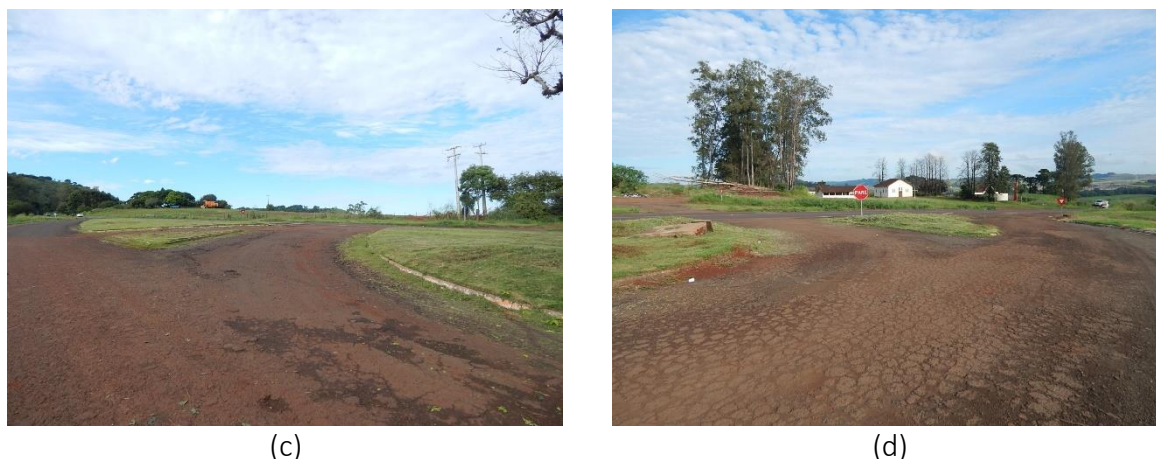
Figura 32. Acesso pela interseção canalizada da rodovia estadual PR 445, km 55.
