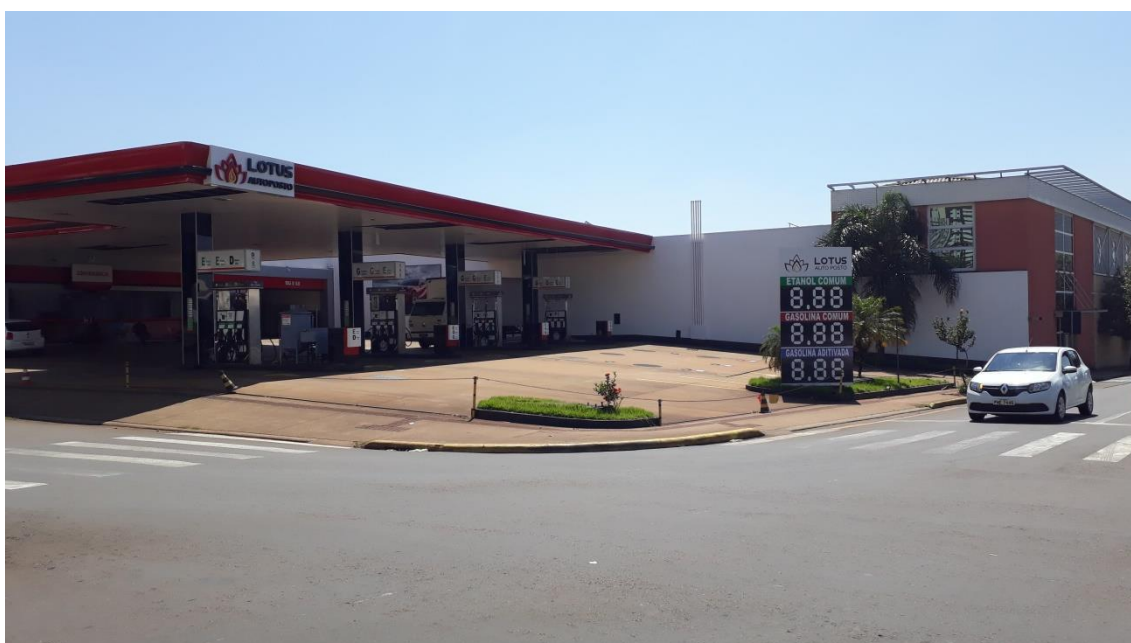
Figura 13 – localização do empreendimento no cruzamento das avenidas Celso Garcia Cid e Jorge Casoni
