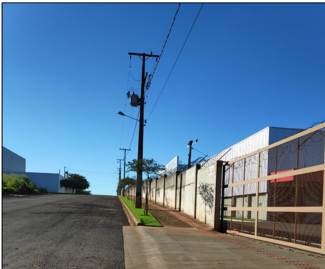
Figura 25 – Calçamento Externo e Via Pública onde encontra-se a Indústria.
