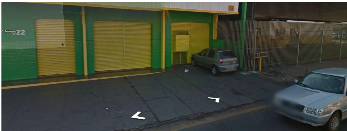
Vista Lateral do Empreendimento – Saída de emergência – Rua Quintino
