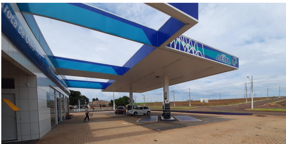
Figura – ausência de muros nos limites do terreno do empreendimento.
