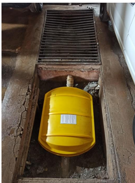
Figura 13: Fotos caixa separadora lava rápido Fonte: Gustavo da Silva, 2021
