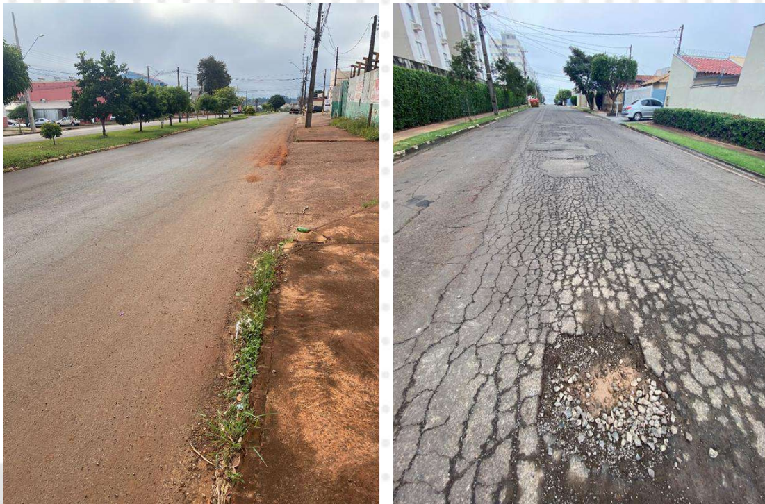
Figura 26: Av. Lucílio de Held à esquerda e Rua Florindo Salvador, à direita.
