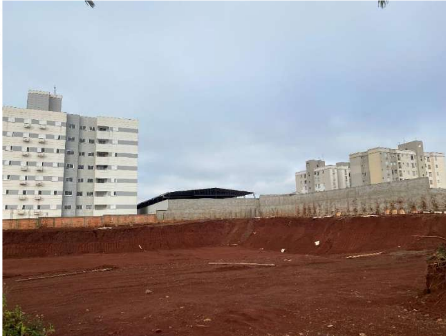
Figura 15: Terraplanagem realizada na área em estudo. Fonte: Brasil Ambiental, 2021.
