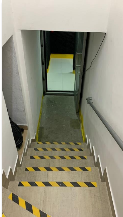
Figura 21– Acesso à pista.
