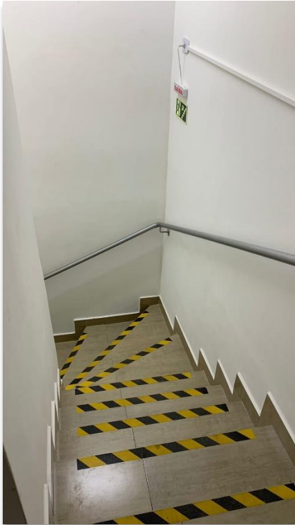
Figura 20 – Acesso à pista.
