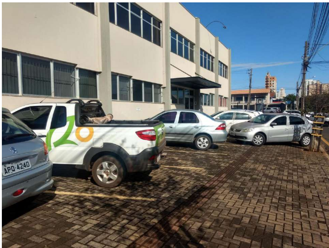
Figura 8.6 - Estacionamento no alinhamento na entrada de serviço, na R. Rio Grande do Norte
