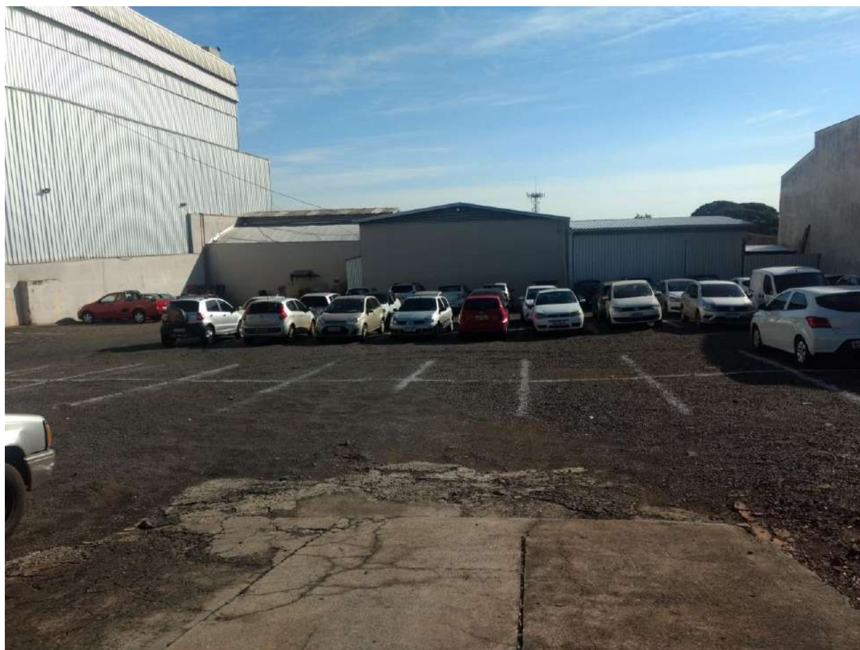
Figura 8.2 - Estacionamentos 1, com entrada pela Rua Acre
