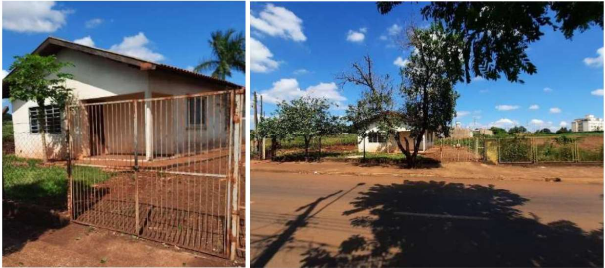
Figura 5: Edificação no lote do empreendimento. Fonte: Master Ambiental, 2022.
