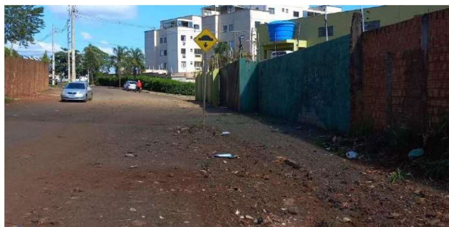
Figura 141: Ausência de sinalização horizontal na Rua Abricó. Fonte: Master Ambiental, 2022.
