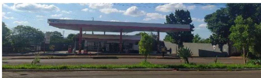
Figura 47: Posto combustível na Av. das Laranjeiras. Fonte: Master Ambiental, 2022.
