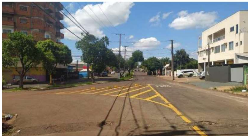
Figura 73: Cruzamento Av. Theodoro Victorelli x Av. das Laranjeiras. Fonte: Master Ambiental (2022).
