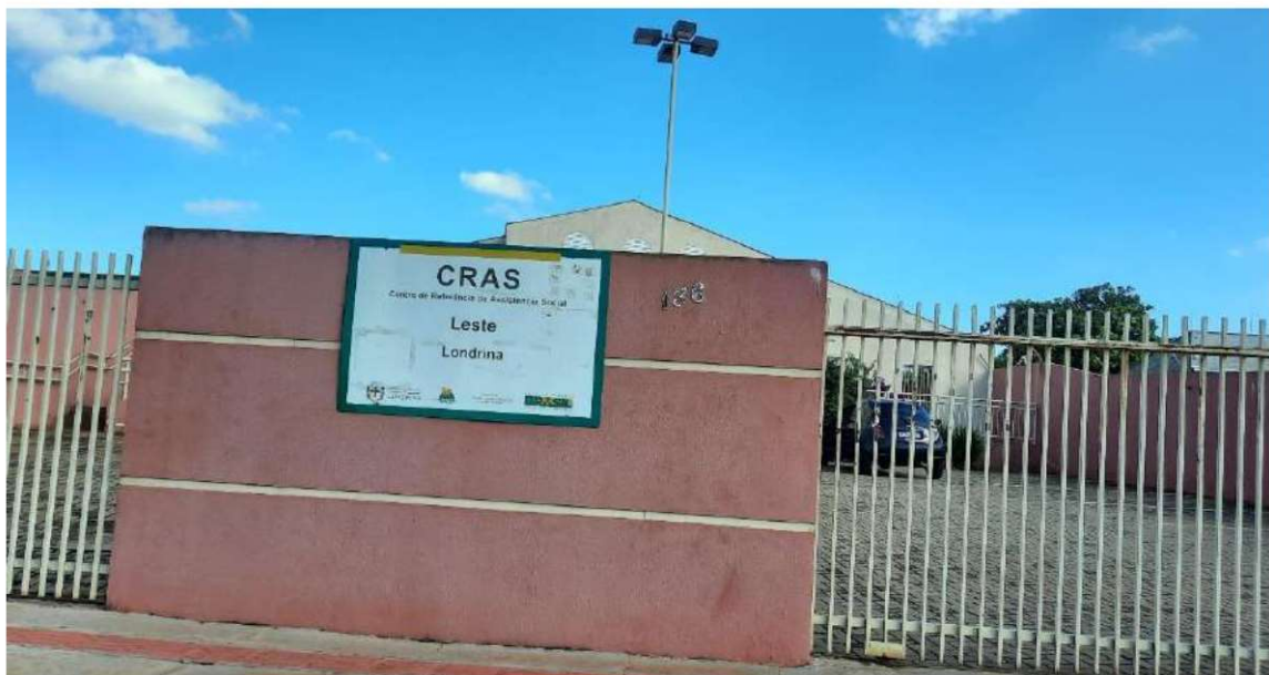
Figura 67: CRAS Zona Leste. Fonte: Master Ambiental, 2022.
