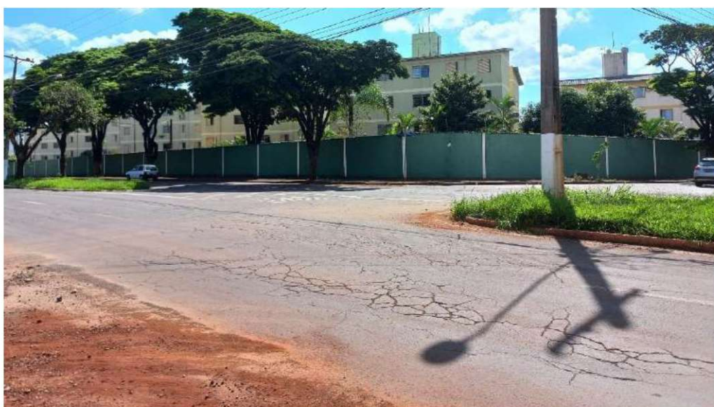
Figura 135: Pavimentação da Avenida das Laranjeiras em frente ao empreendimento. Fonte: Master Ambiental, 2022.
