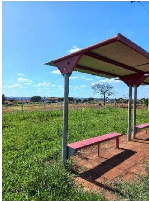
Figura 147: Abrigo de ônibus na Avenida dos Pioneiros. Fonte: Master Ambiental, 2022.
