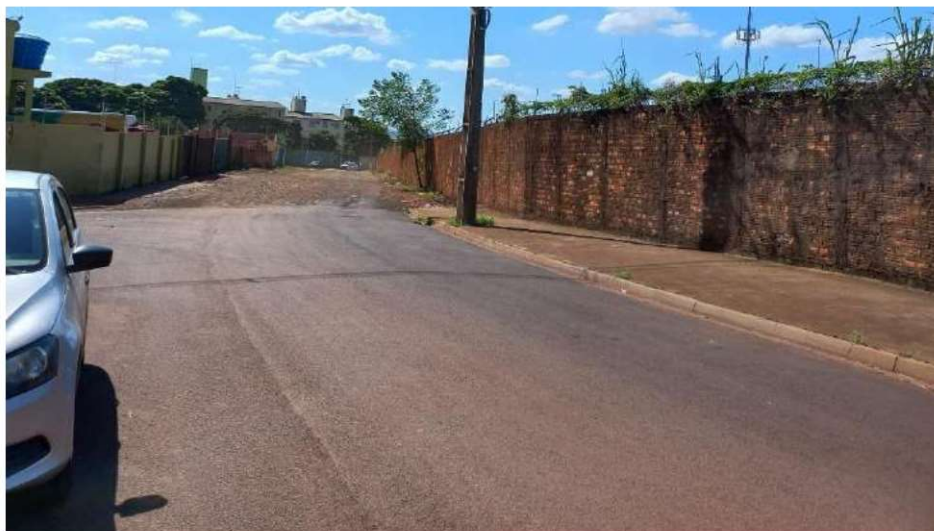
Figura 134: Trecho da Rua Abricó pavimentado. Fonte: Master Ambiental, 2022.
