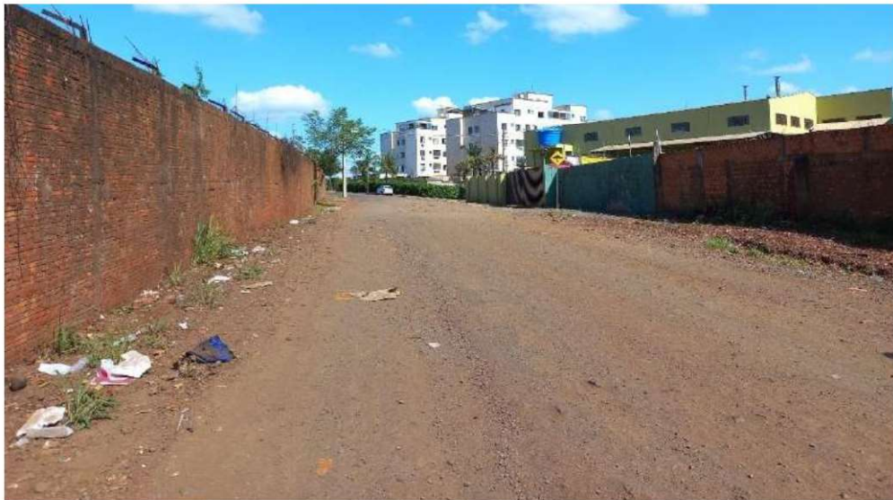
Figura 132: Ausência de pavimentação asfáltica no trecho da Rua Abricó que faz frente com o empreendimento. Fonte: Master Ambiental.
