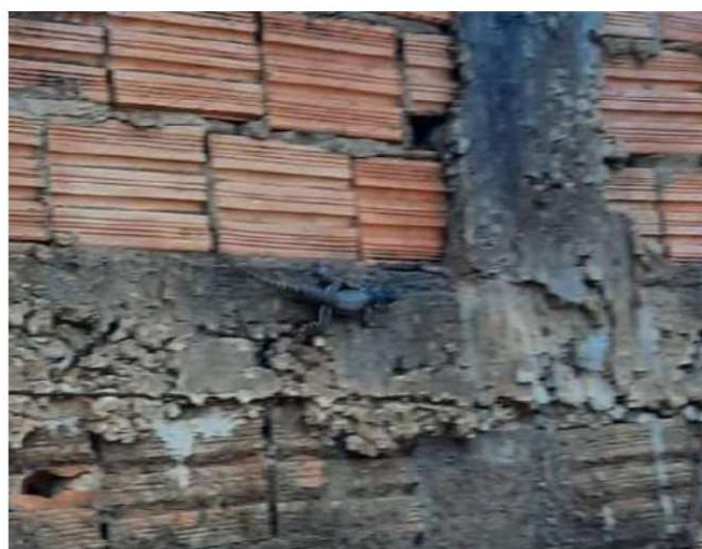
Figura 35: Lagarto no muro do empreendimento. Fonte: Master Ambiental, 2022.
