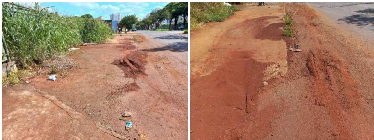
Figura 130: Acúmulo de terra na calçada em frente ao empreendimento, na Avenida das Laranjeiras. Fonte: Master Ambiental, 2022.
