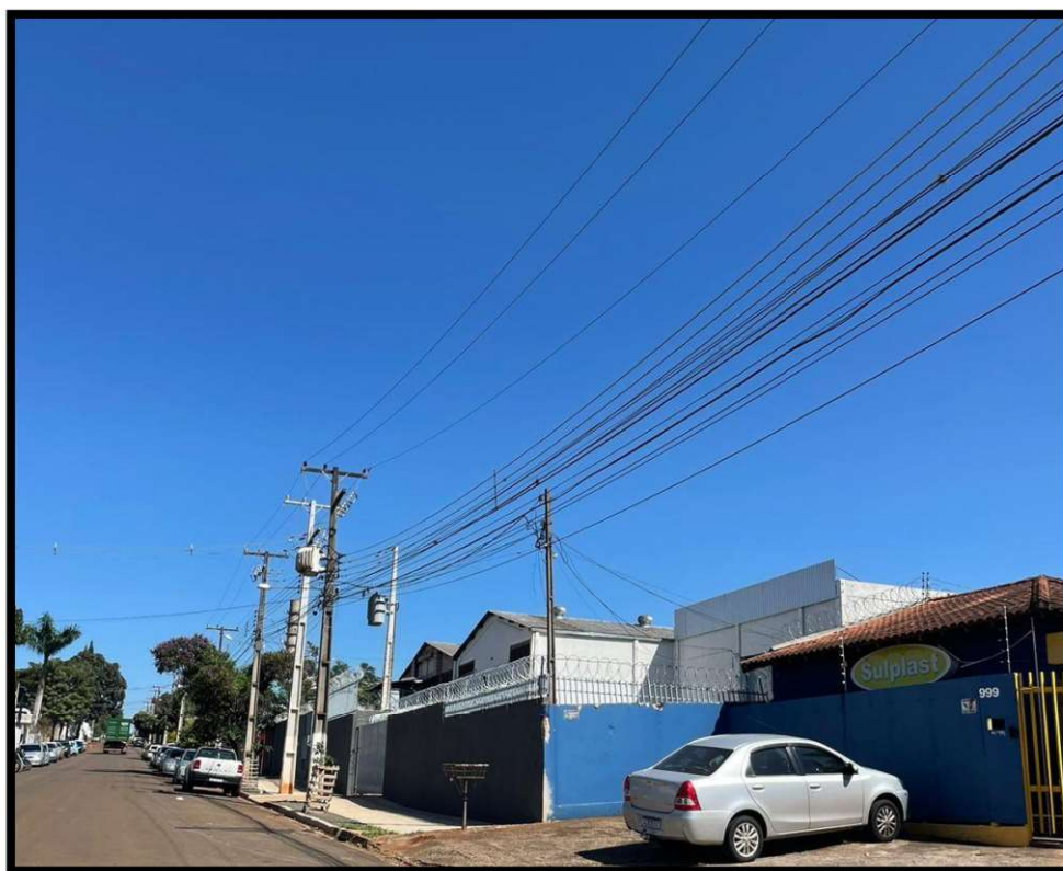
Figura 15: Rede elétrica, Pavimentação asfáltica, Infraestrutura de telecomunicação.
