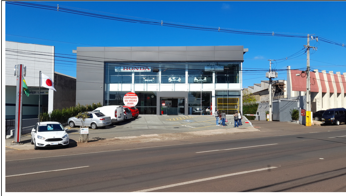
Figura 1: Fachada Empreendimento -PRIXX VEÍCULOS LTDA
