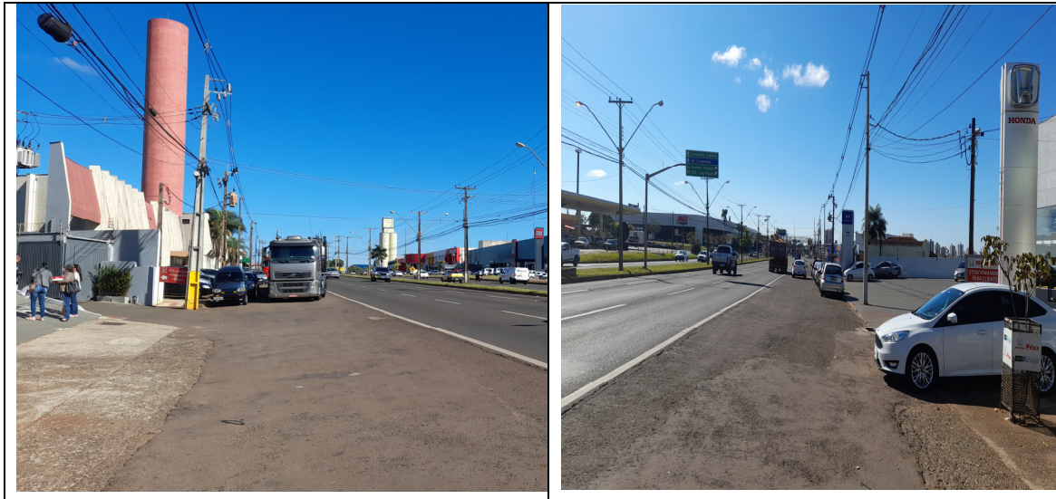
Figura 2 e 3. Via de acesso principal: Av. Tiradentes
