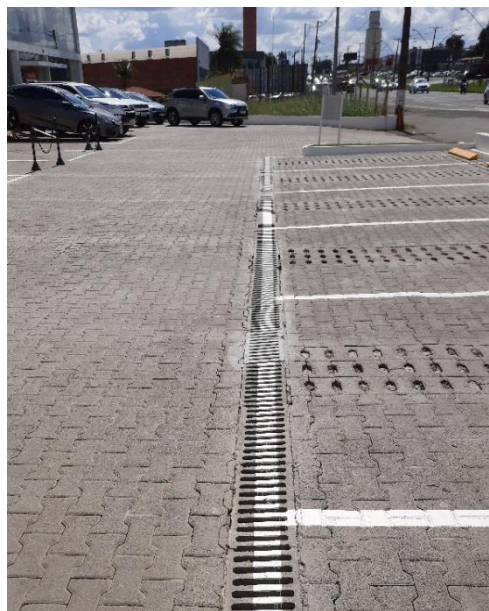
Figura 45: Drenagem no Lote nº 9-C/10-C-1. Fonte: Master Ambiental.
