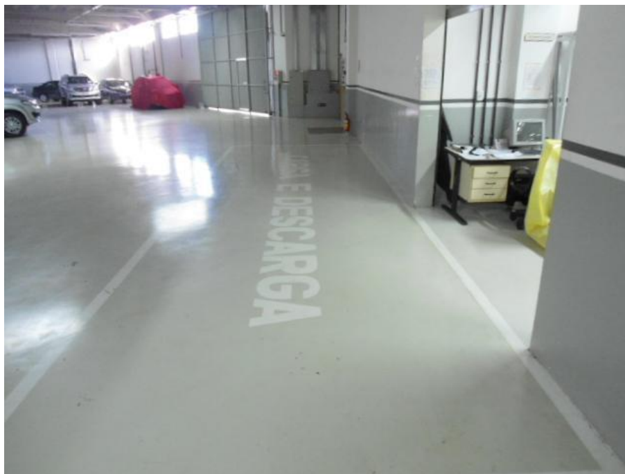
Figura 66: Local de carga e descarga de materiais. Fonte: Empreendedor.
