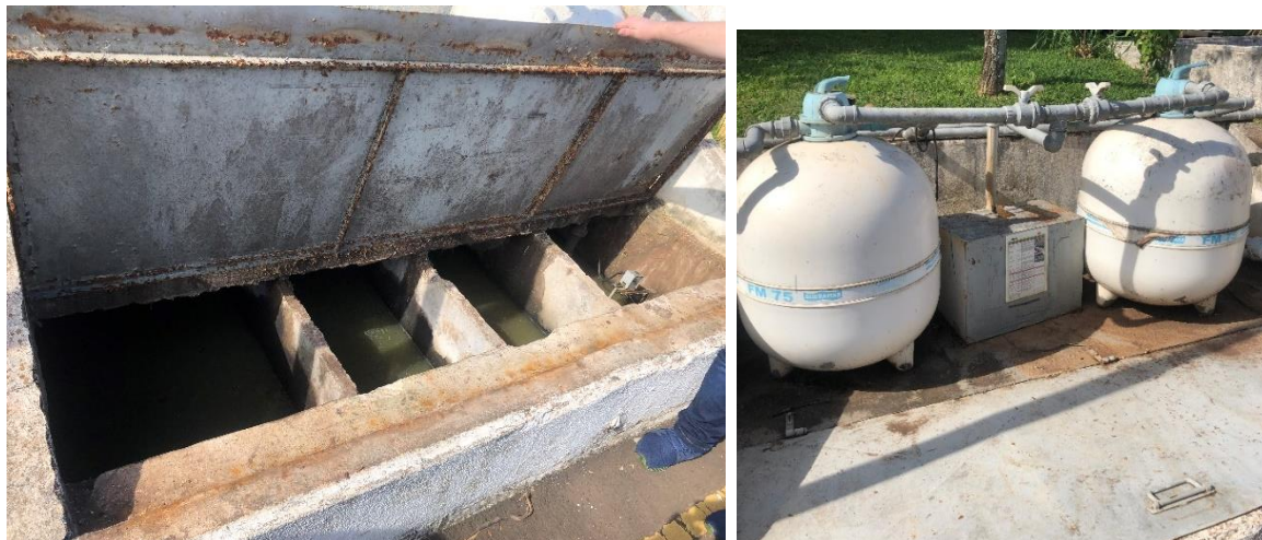
Figura 18: Sistema de tratamento de efluentes/Caixa de separação água e óleo. Fonte: Master Ambiental.
