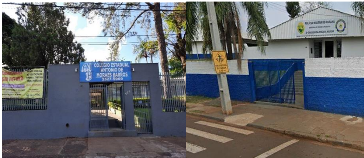
Figura 48: Equipamentos de Ensino na Área de Influência do Empreendimento. Fonte: Master Ambiental.
