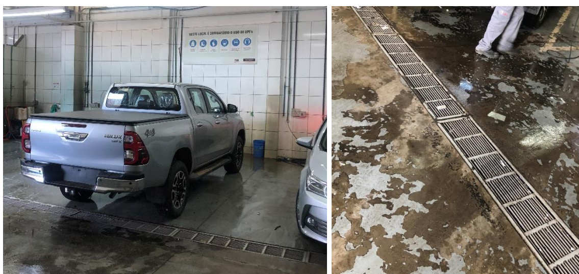
Figura 21: Sistema de lavagem de veículos. Fonte: Master Ambiental.
