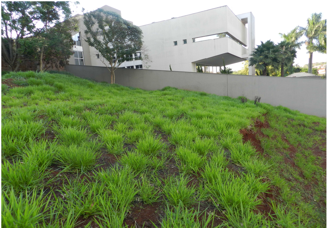
Foto 10: Hospital Araucária: gabarito.
