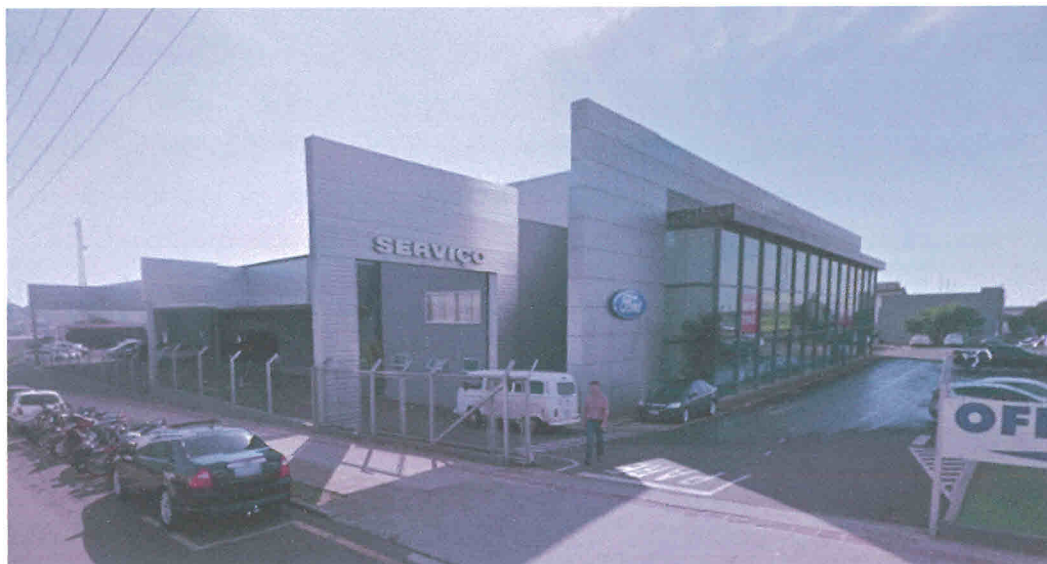
Figura 05: Acesso ao empreendimento (Rua Seimu Oguido).
