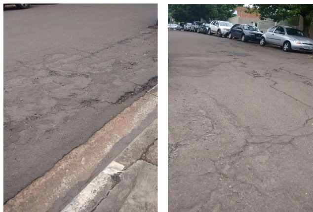
Figura 9: Pavimentação da Rua Borba Gato.
