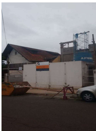
Figura 1: Terreno onde está sendo construído o empreendimento.
