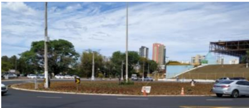
Figura 38: Rotatória da Alameda Julio de Mesquita Filho com Av. Bandeirantes. Fonte: Master Ambiental, 2019.
