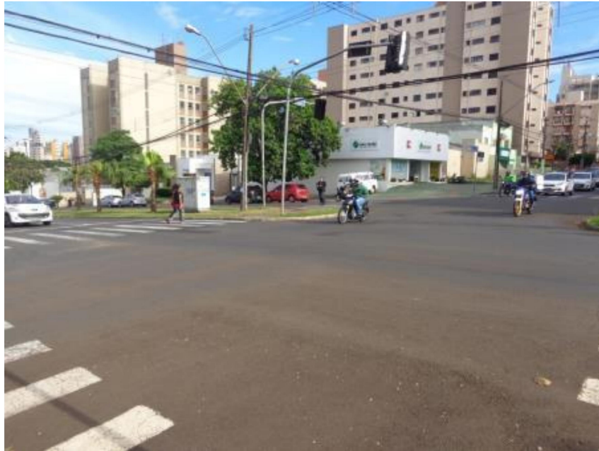
Figura 60: Cruzamento Avenida Juscelino Kubitschek com Rua Senador Souza Naves. Fonte: Master Ambiental, 2019.
