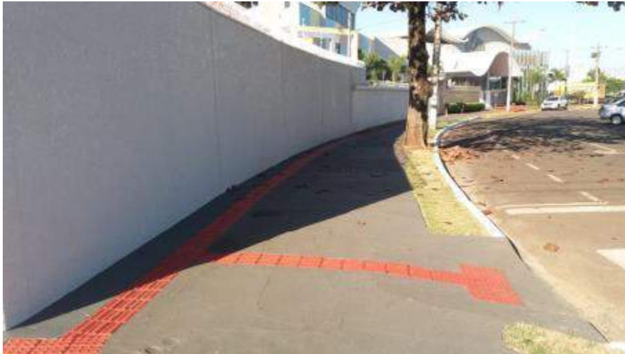
Figura 95: Calçada do Colégio Adventista com presença de sinalização tátil, área de serviço e passeio pavimentado conforme a NBR 9050/2015. Fonte: Master Ambiental, 2019.
