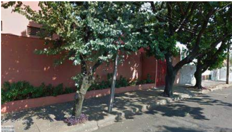
Figura 89: Passeio na Rua Castro Alves, não apresentando faixa de serviço e sinalização tátil. Fonte: Google Earth, 2017.
