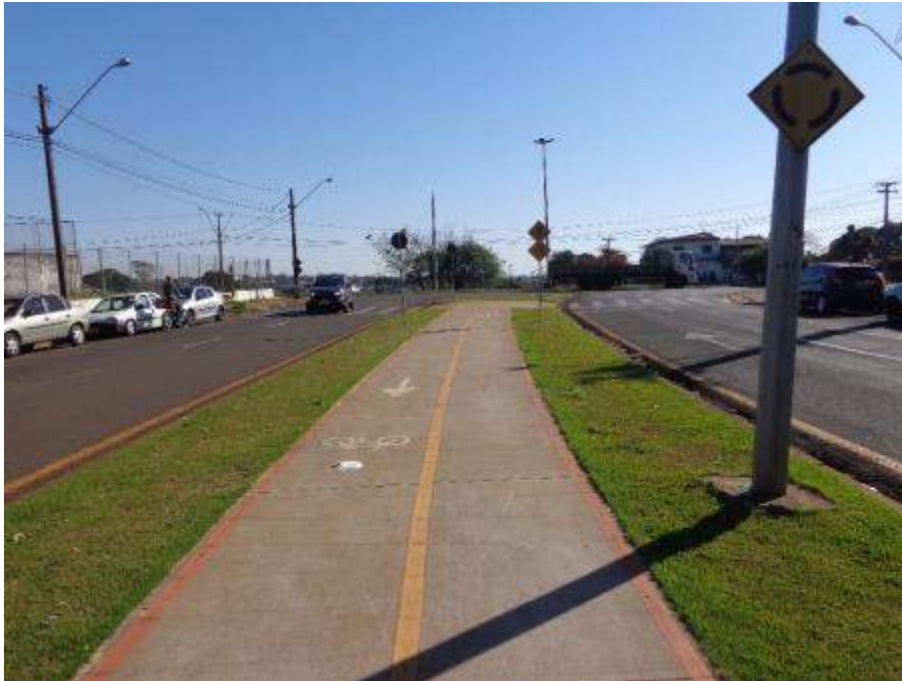
Figura 51: Trecho Avenida Universo. Fonte: Master Ambiental, 2019.
