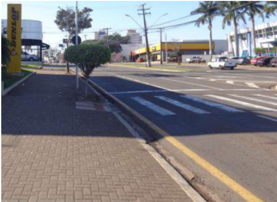
Figura 79: Condições de pavimentação e sinalização da Av. Tiradentes. Fonte: Master Ambiental, 2019.
