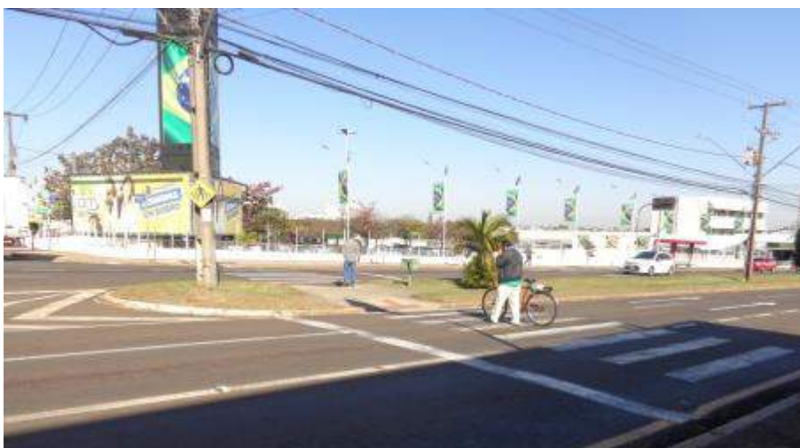
Figura 80: Condições de pavimentação e sinalização da Av. Tiradentes. Fonte: Master Ambiental, 2019.
