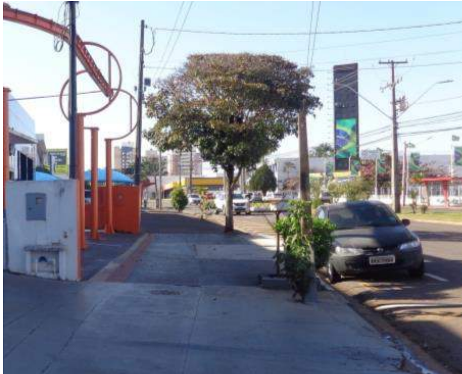
Figura 90: Passeio na Avenida Tiradentes, não apresentando faixa de serviço e com sinalização tátil descontínua. Fonte: Master Ambiental, 2019.
