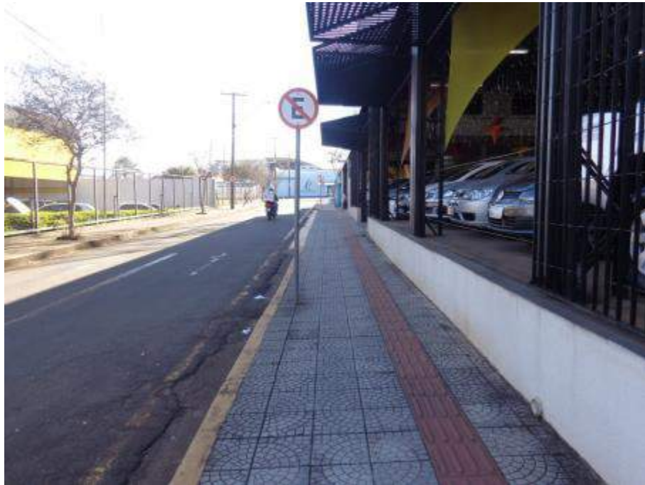
Figura 81: Condições de pavimentação e sinalização da Rua Paulo Setúbal. Fonte: Master Ambiental, 2019.
