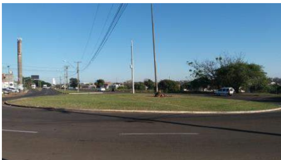
Figura 54: Rotatória, ponto de encontro entre as Avenidas Abelio Benatti e Universo. Fonte: Master Ambiental, 2019.
