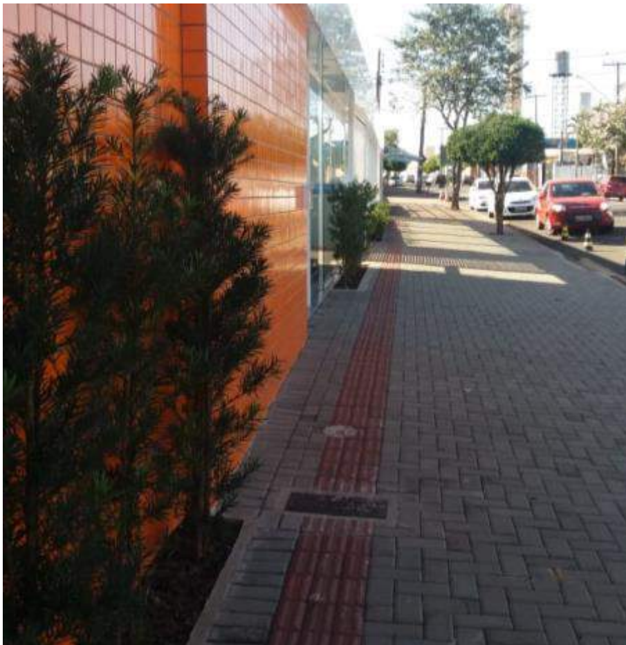
Figura 96: Passeio do empreendimento na Rua Castro Alves, presença de sinalização tátil e ausência de faixa de serviço. Fonte: Master Ambiental, 2019.
