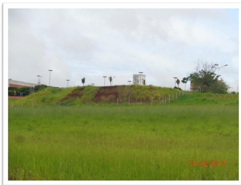
Figura 8: Talude que sustenta o terreno Fonte: Master Ambiental
