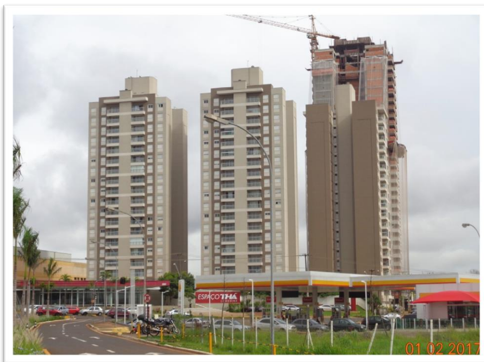
Figura 25: Caracterização de usos praticados e novas construções. Fonte: Master Ambiental, 2017.
