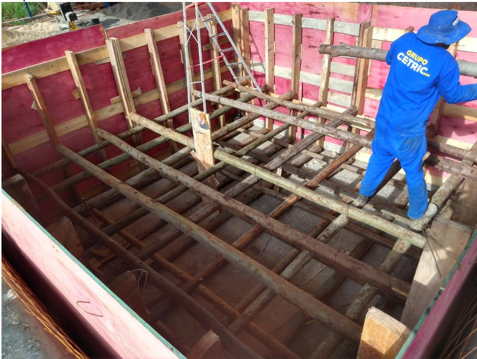
Imagem 5 – Instalação de vala de solidificação/estabilização padrão Grupo CETRIC: Fase 5 – Escoramento das paredes
