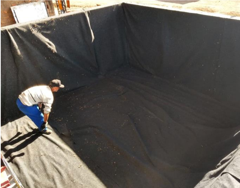
Imagem 1 – Instalação de vala de solidificação/estabilização padrão Grupo CETRIC: Fase 1 - Colocação de manta geotêxtil
