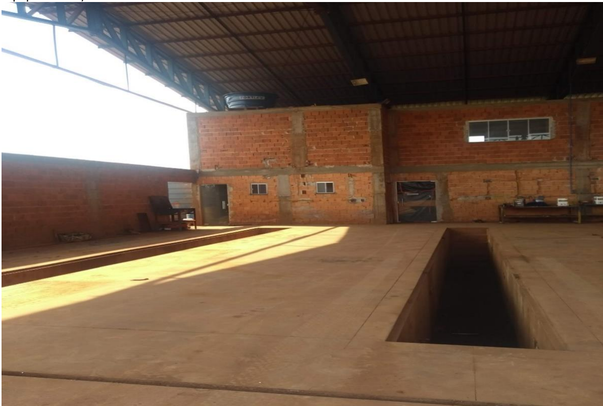
Imagem 9 – Visão interna do barracão 02 (Rampa de Manutenção/Lavagens de máquinas e equipamentos)
