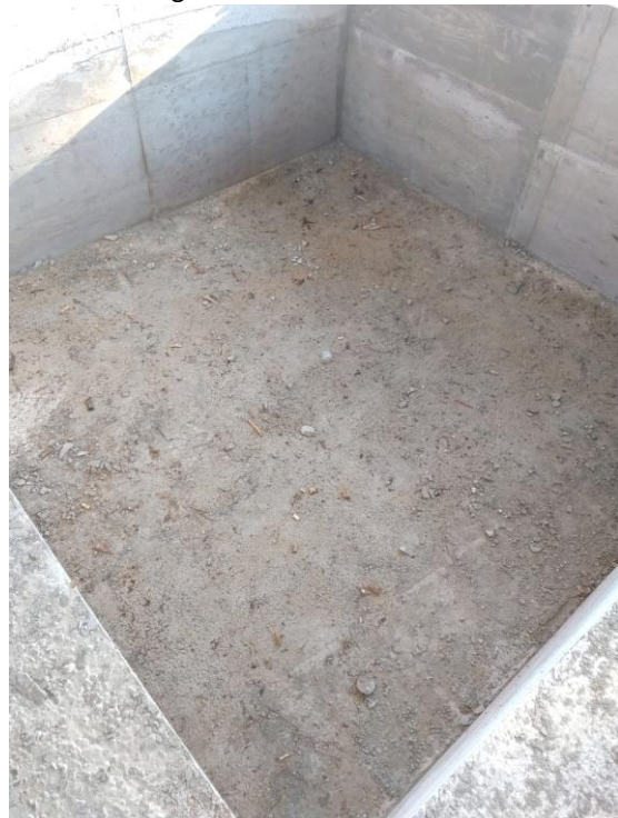
Imagem 7 – Instalação vala padrão Grupo CETRIC: Fase 7 – Secagem da vala
