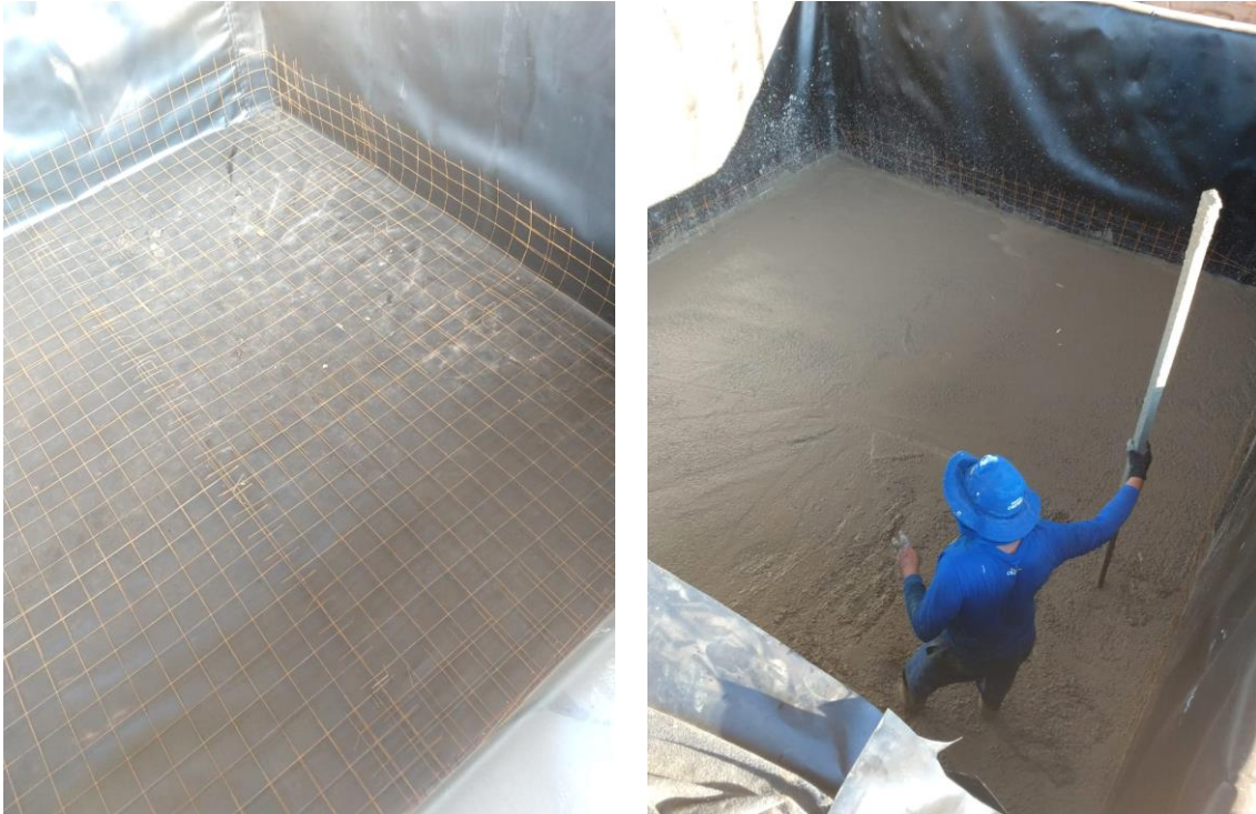
Imagem 3 e 4 – Instalação de vala de solidificação/estabilização padrão Grupo CETRIC: Fase 3 e 4 - Colocação de malha de ferro e cimentação do fundo da vala
