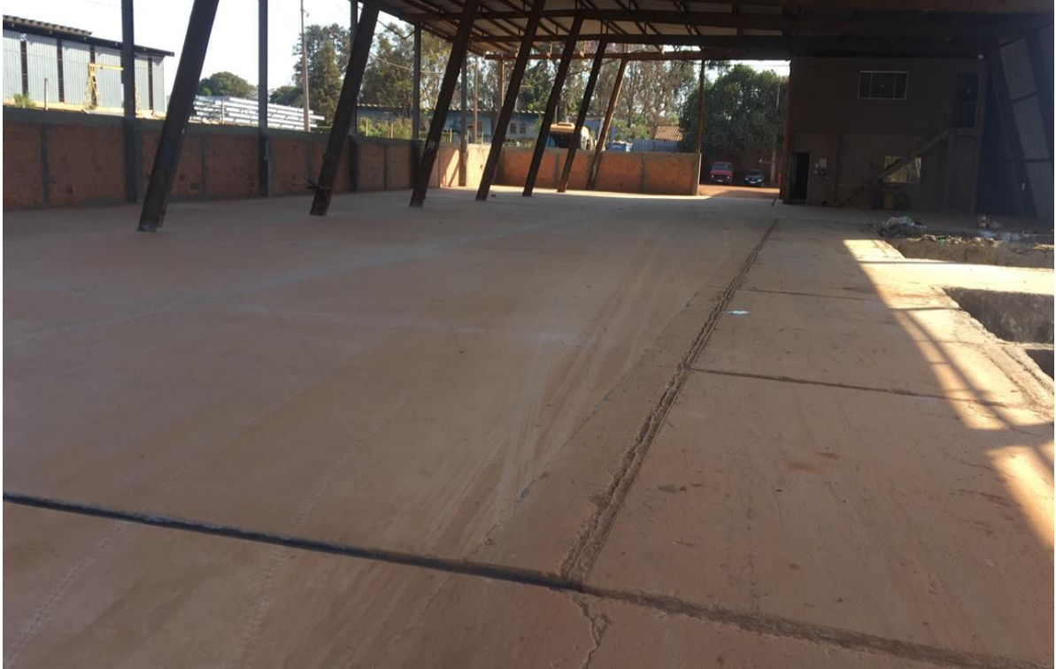
Imagem 8 – Visão interna do barracão 01 - Valas de solidificação/estabilização, a direita, e restante do piso impermeabilizado, com canaletas coletoras e contenção para evitar a entrada de água pluvial, a esquerda
