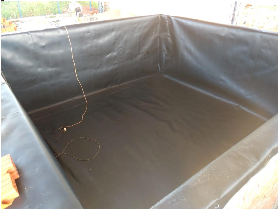
Imagem 2 – Instalação de vala de solidificação/estabilização padrão Grupo CETRIC: Fase 2 - Colocação de geomembrana PEAD 2mm
