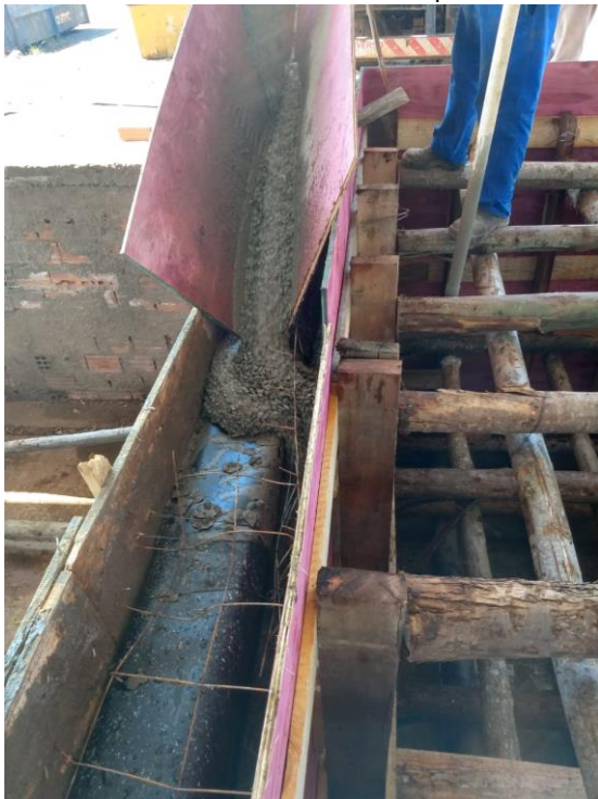
Imagem 6 – Instalação de vala padrão Grupo CETRIC: Fase 6 – Preenchimento dos moldes pareces
