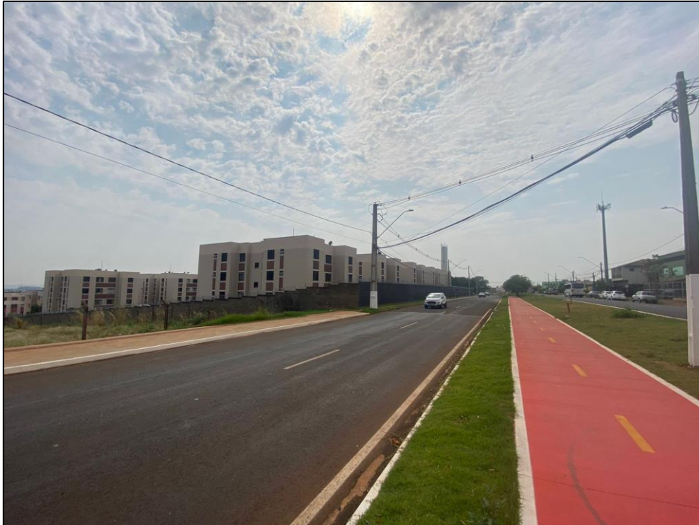
Figura 9 - Registro fotográfico do entorno do empreendimento em Londrina, Paraná.
