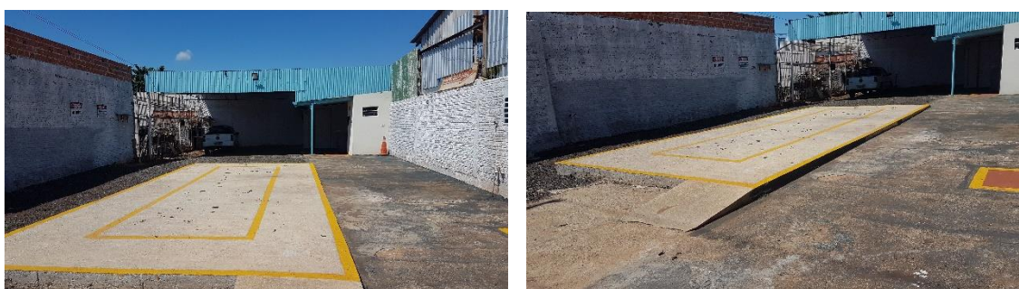
Figura 1. Revenda; Cobertura e local para carga e descarga e pátio de manobra para entrada de caminhões.
