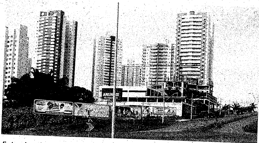
Figura 12: Vista do alto da Palhano e os diversos prédios construídos.
