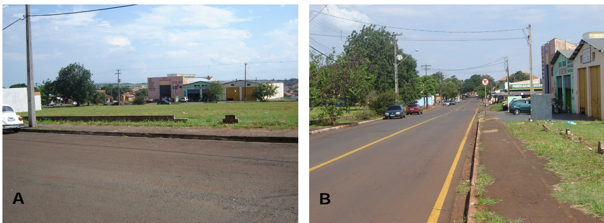
Figura 20: Pavimentação do local.
