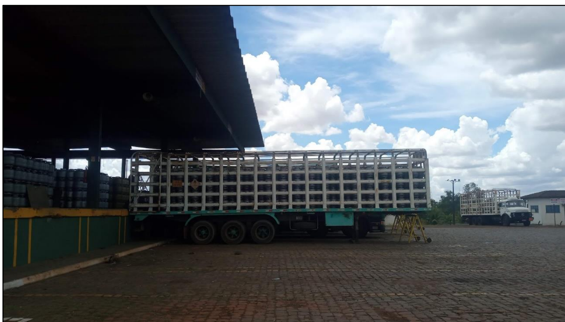
Figura 5. Área de carregamento. Fonte: LL Ambiental, 2023.
