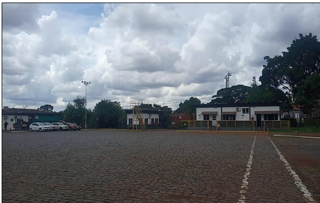
Figura 150. Pátio para estacionamento de mais veículos. Fonte: LL Ambiental, 2023.
