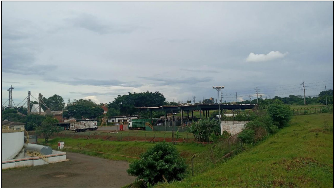
Figura 126. Edificação volumétrica existente no empreendimento. Fonte: LL Ambiental, 2023.
