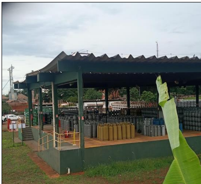
Figura 4. Área de armazenamento. Fonte: LL Ambiental, 2023.
