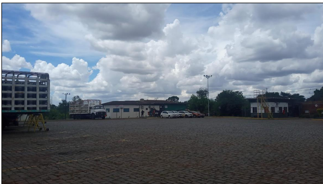
Figura 3. Área do pátio do empreendimento. Fonte: LL Ambiental, 2023.
