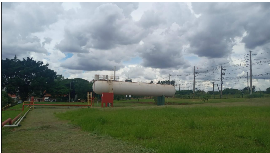
Figura 128. Edificação volumétrica existente no empreendimento. Fonte: LL Ambiental, 2023.
