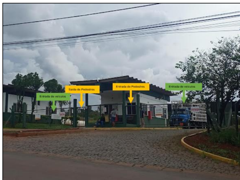
Figura 154. Entrada ao empreendimento. Fonte: LL Ambiental, 2023.
