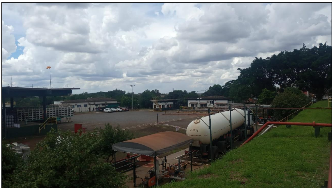
Figura 127. Edificação volumétrica existente no empreendimento. Fonte: LL Ambiental, 2023.
