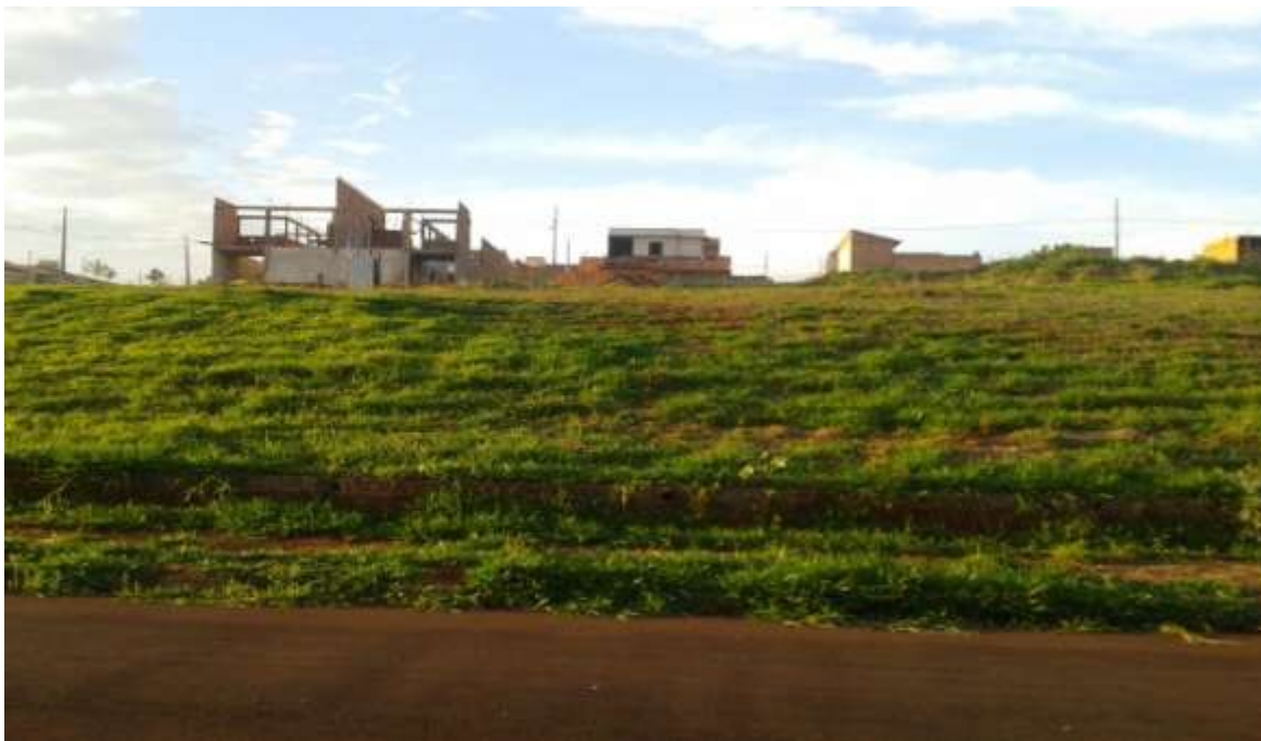
Figura 9: Área do empreendimento, bairro Central Park Residence.
