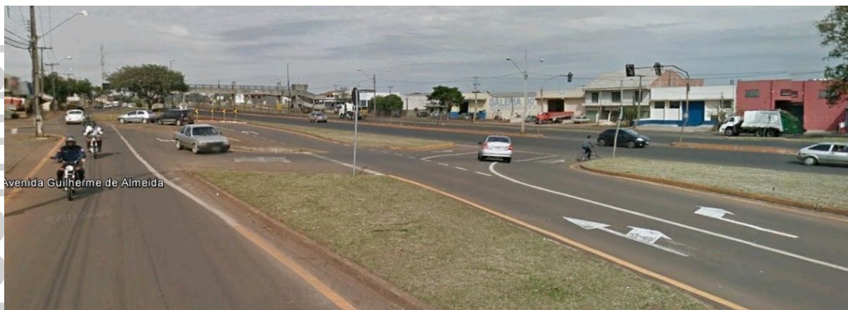
Figura 56: Vista da Avenida Guilherme de Almeida e sinalização horizontal e vertical no ponto de cruzamento com a PR 445.
