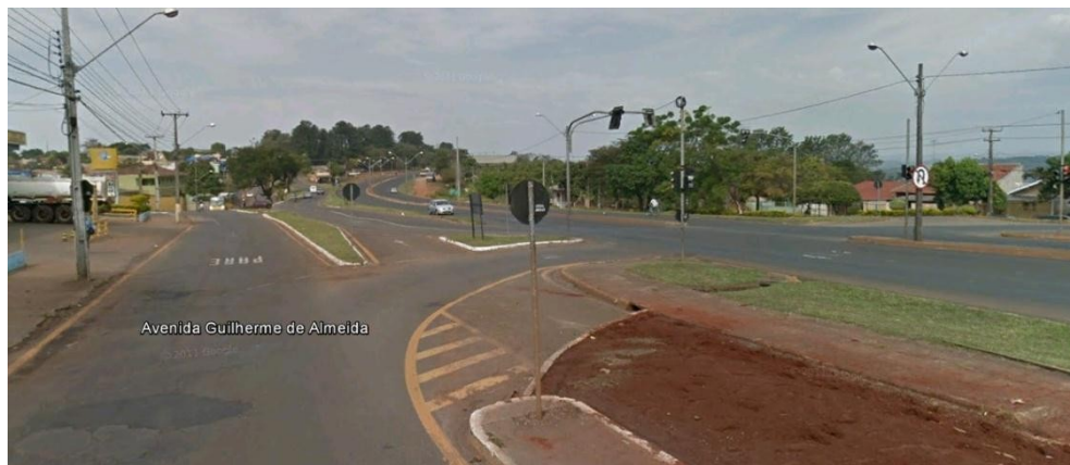
Figura 58: Vista da Avenida Guilherme de Almeida, quando a mesma volta a ser mão dupla e separada por canteiro central. Fonte: Google Street View (2012).
