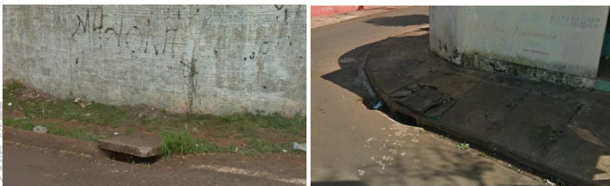
Figura 30: Vista de bueiro implantado na Rua dos Cozinheiros e da Rua Sapateiros, respectivamente.
