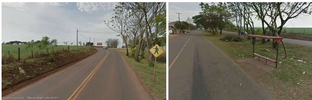
Figura 29: Vista frontal do empreendimento para a Avenida Guilherme de Almeida com a infraestrutura de pavimentação e da Rua dos Cozinheiros, próximo a área do lote proposto, respectivamente.
