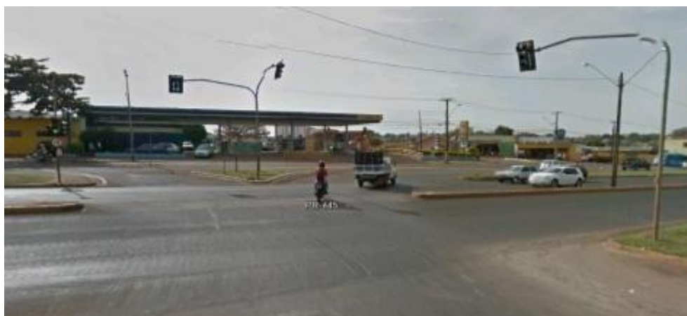
Figura 49: Vista do acesso da PR-445 à Avenida Guilherme de Almeida. Fonte: Google Street View (2012).
