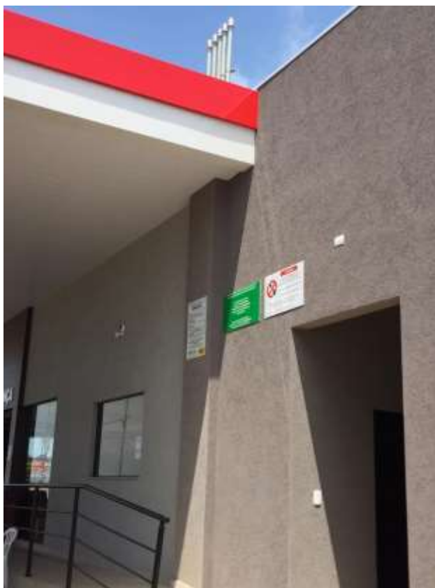
Figura 5 – respiradores dos tanques de abastecimento de combustível Foto – Próprio autor
