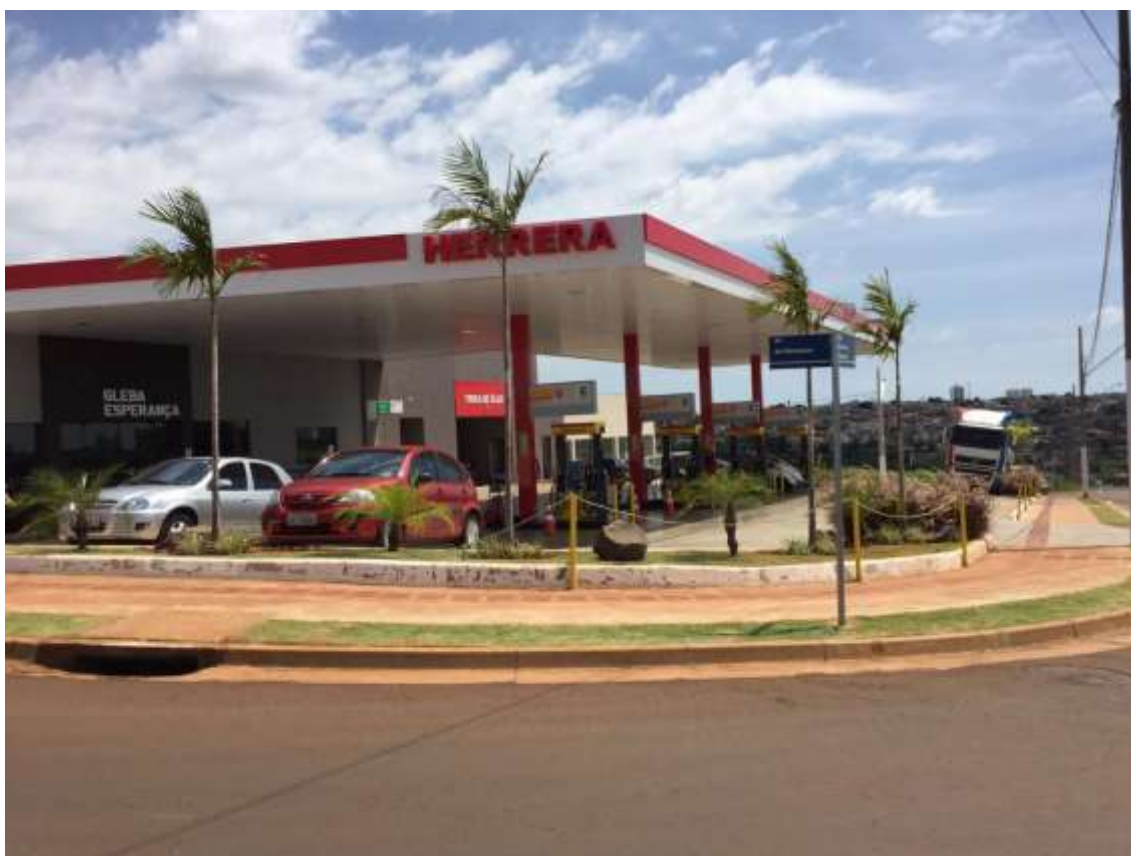
Figura 6 – estrutura que permite circulação de ar Foto – Próprio autor
