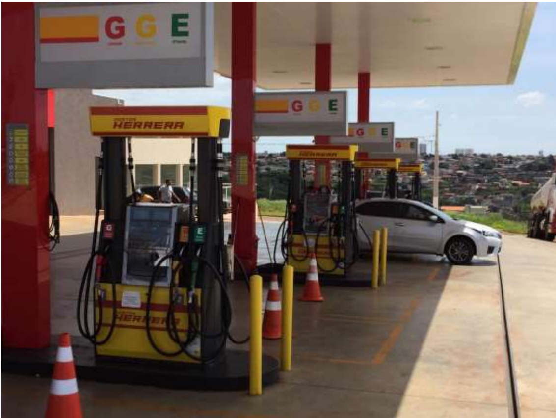
Figura 1 – Pátio de abastecimento Foto – Próprio autor
