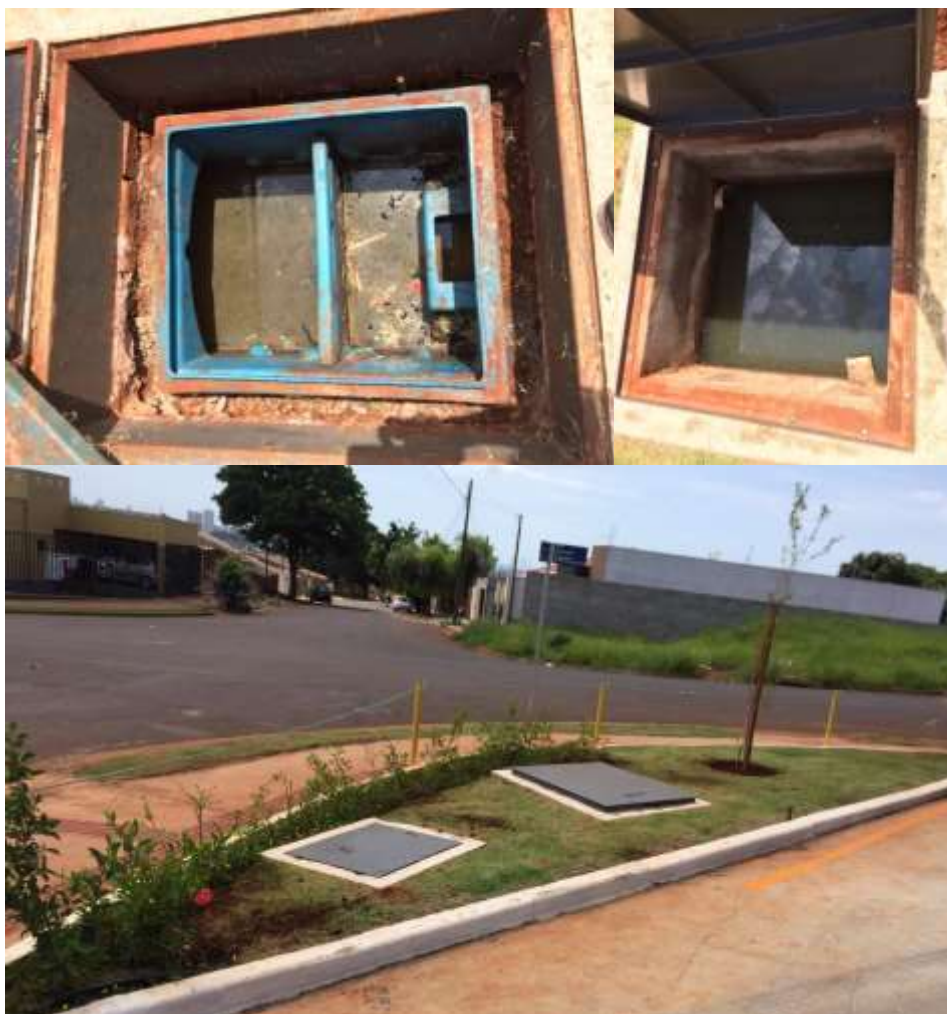
Figura 9 – Sistema de células coalescentes separador de efluente óleo e água
