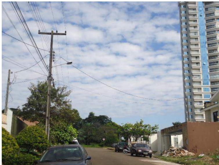
Figura 83: Poste instalado na Rua Marcondes de Oliveira. Fonte: Master Ambiental, 2016.
