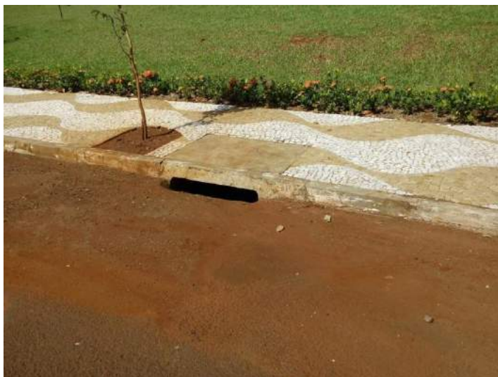
Figura 42: Pavimentação, Rua Mario Diniz de Oliveira. Fonte: Master Ambiental, 2016.
