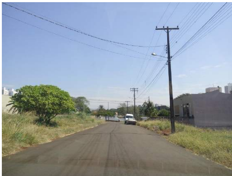
Figura 84: Poste de iluminação instalado na Rua Neila Ribeiro. Fonte: Master Ambiental, 2016.
