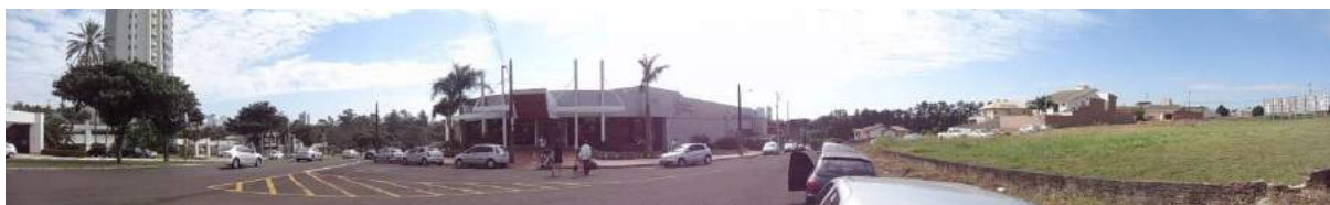
Figura 75: Fotografia: Vista panorâmica do empreendimento. Fonte: Master ambiental, 2016.
