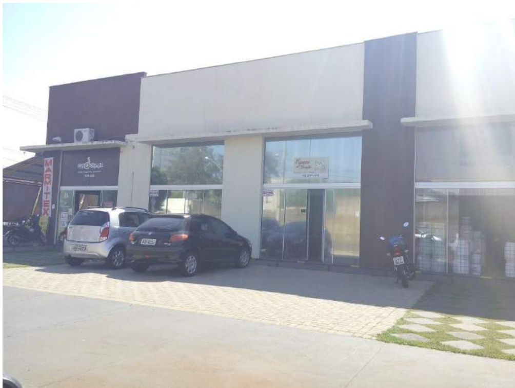
Figura 21: Fotografia Comércio e Serviço Local Av. Garibaldi Deliberador. Fonte: Master Ambiental, 2016.
