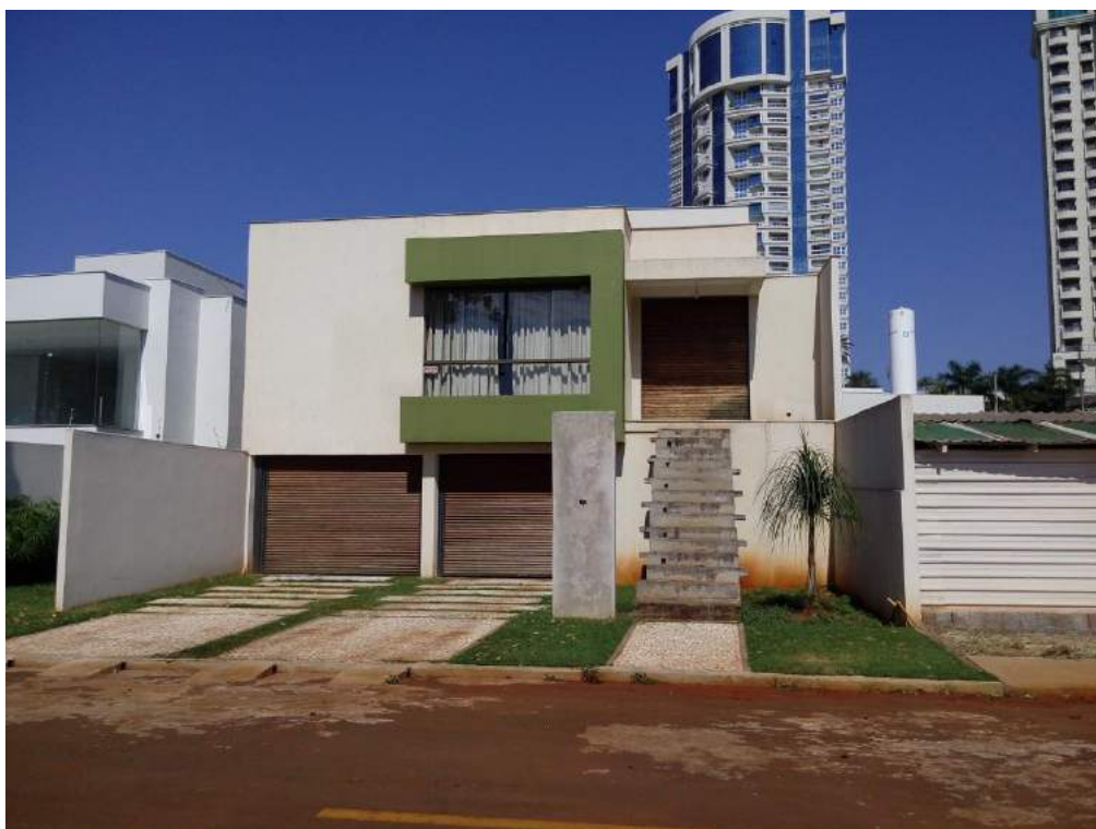
Figura 26: Fotografia – residencial unifamiliar, R. Otaviano Gonçalves Ferreira. Fonte: Master Ambiental, 2016.
