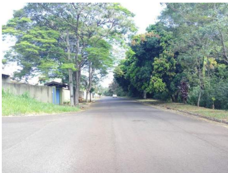
Figura 41: Sinalização Ausente, Rua Mario Diniz de Oliveira. Fonte: Master Ambiental, 2016.
