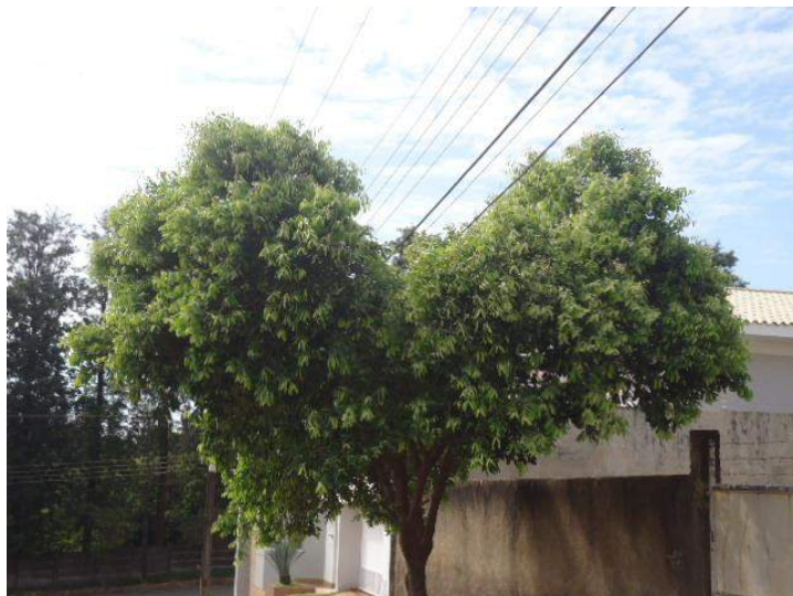
Figura 66: Árvore podada para evitar conflito com a fiação elétrica (Rua Marcondes de Oliveira).
