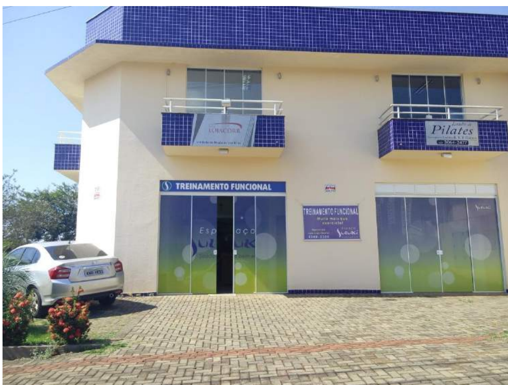
Figura 22: Fotografia Comércio e Serviço Local Av. Garibaldi Deliberador. Fonte: Master Ambiental, 2016.
