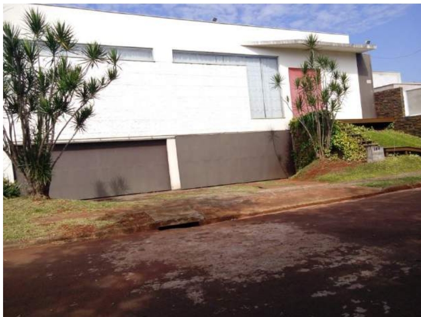
Figura 45: Pavimentação, Rua Neila Ribeiro. Fonte: Master Ambiental, 2016.
